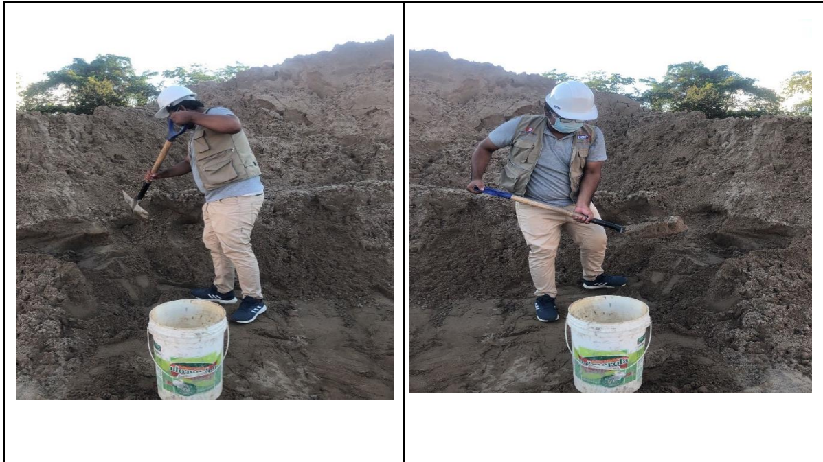
Fotos n° 01-02: En las imágenes se puede apreciar el muestreo de los agregados para la realización del diseño.
