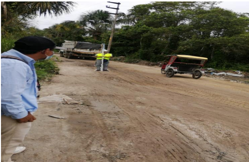
foto N° 15 termino de las pruebas de carga controlada, toma de datos
