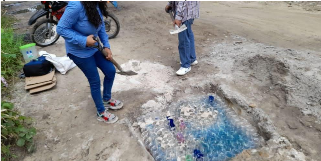
foto N° 9 Colocación de paneles de botella de plástico
