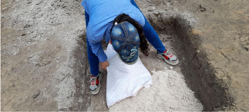
foto N° 6 Colocación del manto de arena blanca
