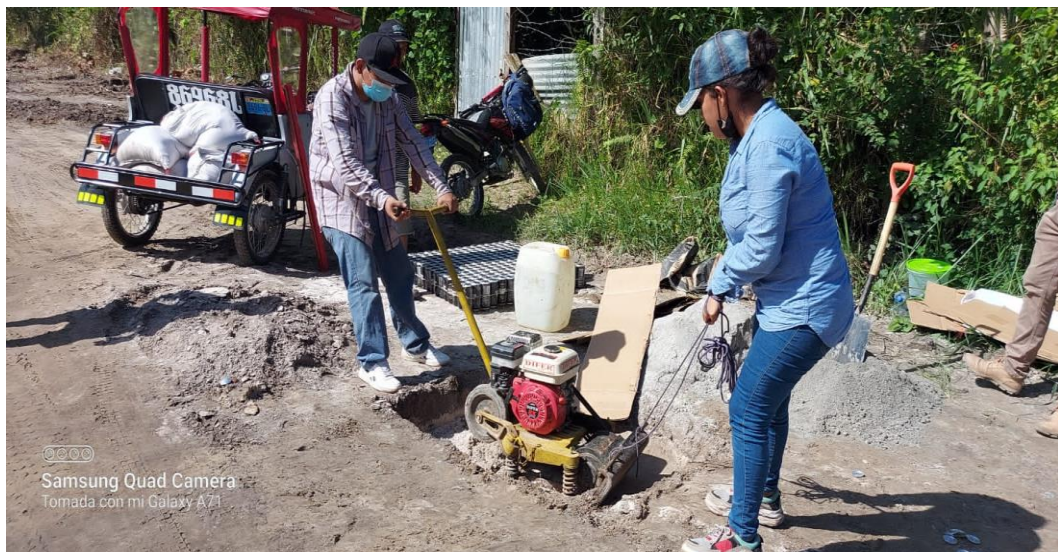
foto N° 7 densificación del área a trabajar
