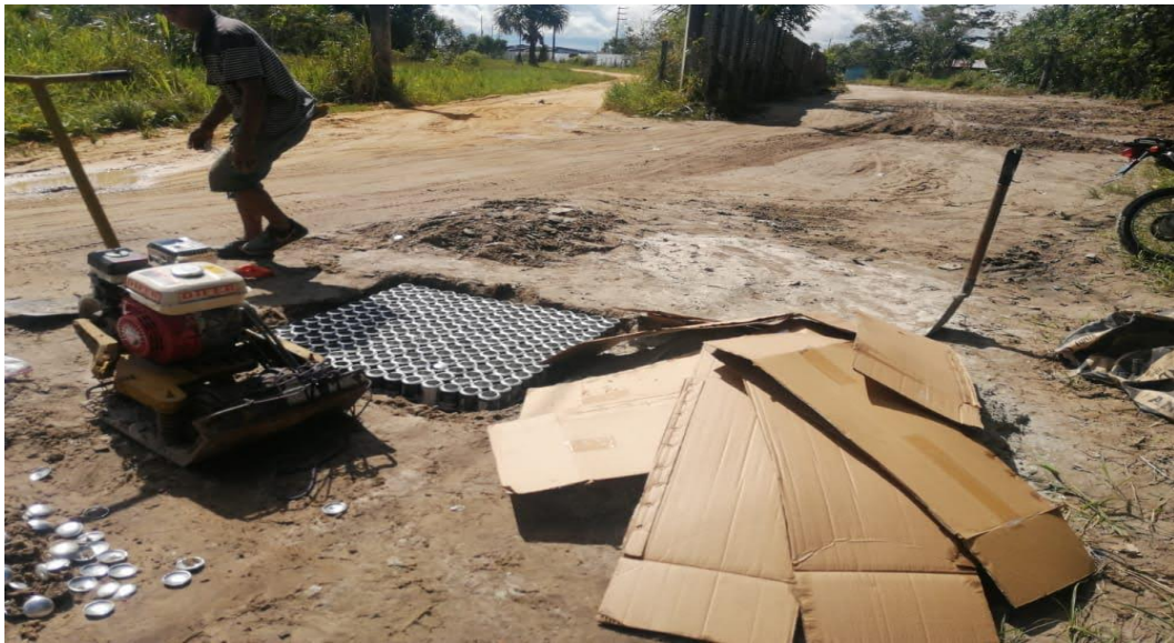
foto N° 8 Colocación de paneles de aluminio
