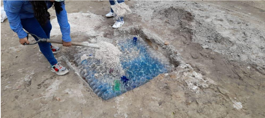
foto N° 10 el trabajo de relleno en la geomalla de botella de plástico
