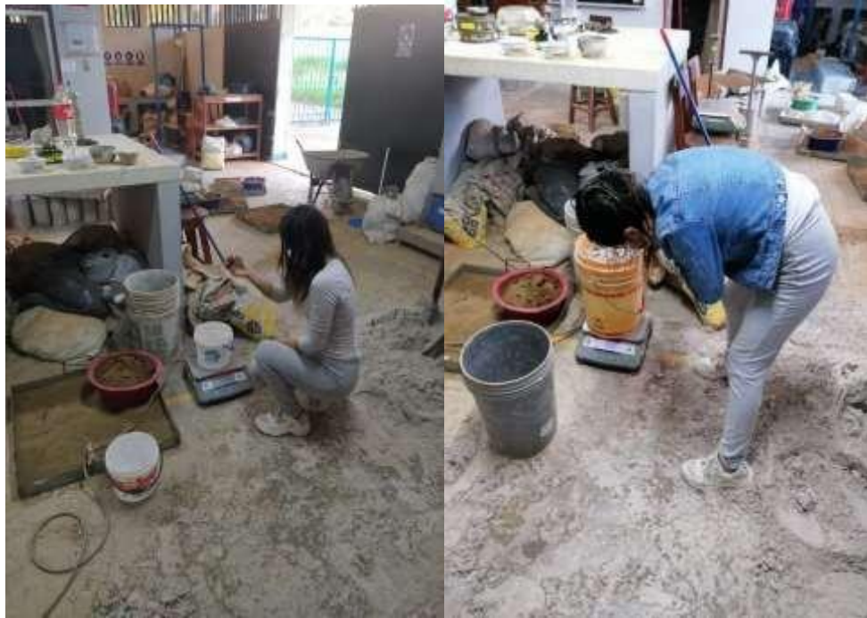
Foto 3. Proceso de dosificación para la elaboración de la mezcla para los bloques
