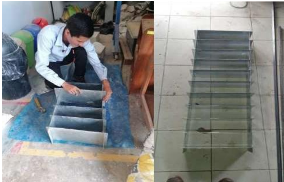
Foto 1. Se realizó el proceso de armado de los moldes de aluminio de espesor de 3 mm para los bloques.
