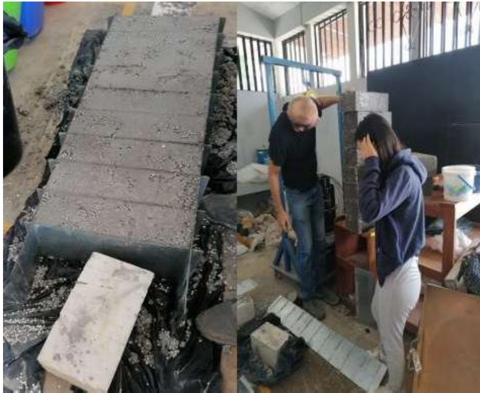
Foto 7. Desencofrado de los bloques al día siguiente de la colocación de la mezcla en los moldes, para ser llevados a curar los 7 días posteriores respectivos.
