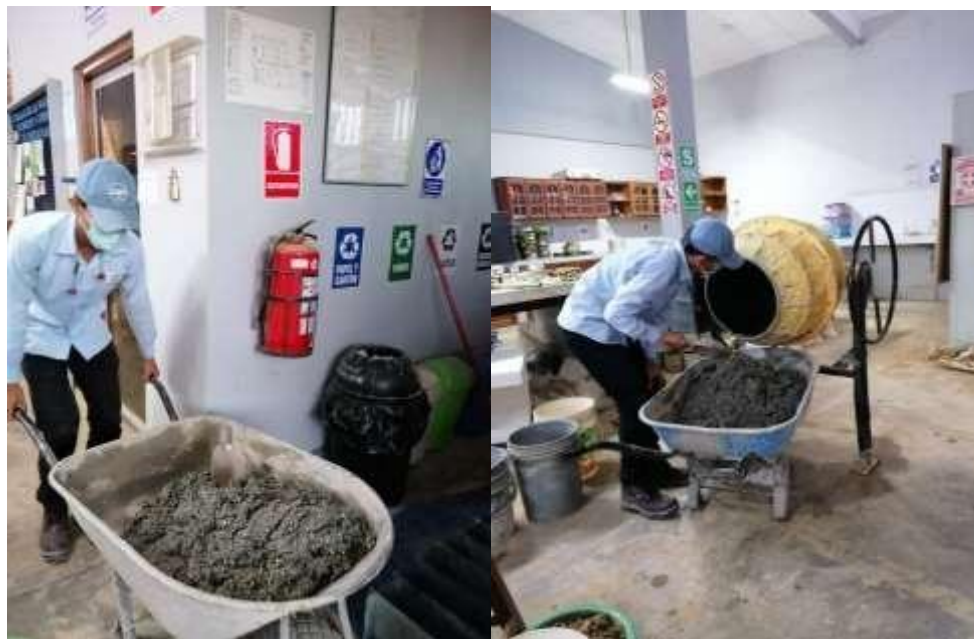
Foto 4. Ejecución de la mezcla para los bloques
