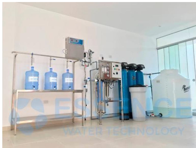
Figura 4 Planta de producción de agua de mesa
