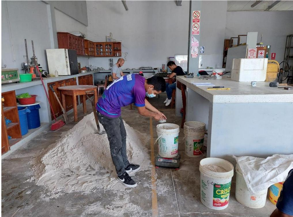
FOTO N° 22: Materiales listos para su posterior vaciado en la mezcladora (Trompo de 9 pies 3)
