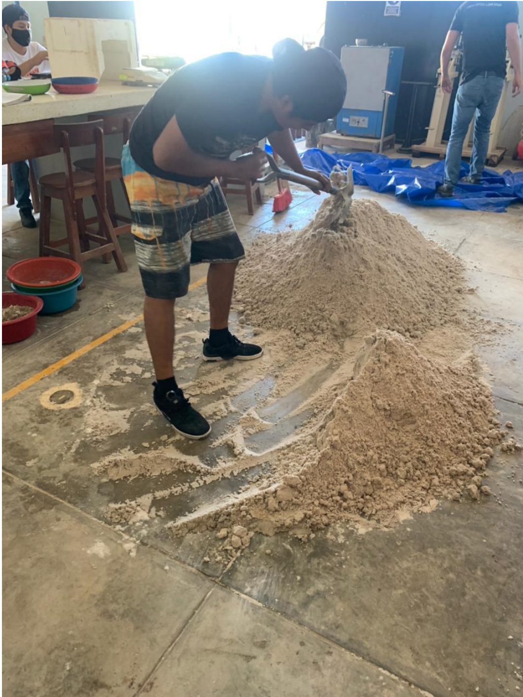
Mezclado y uniformización de la humedad del agregado fino.
