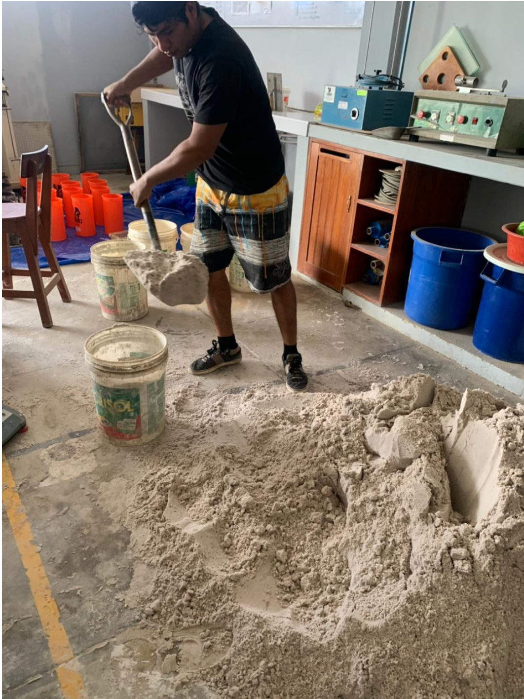
Pesaje del agregado fino para realización de la mezcla.
