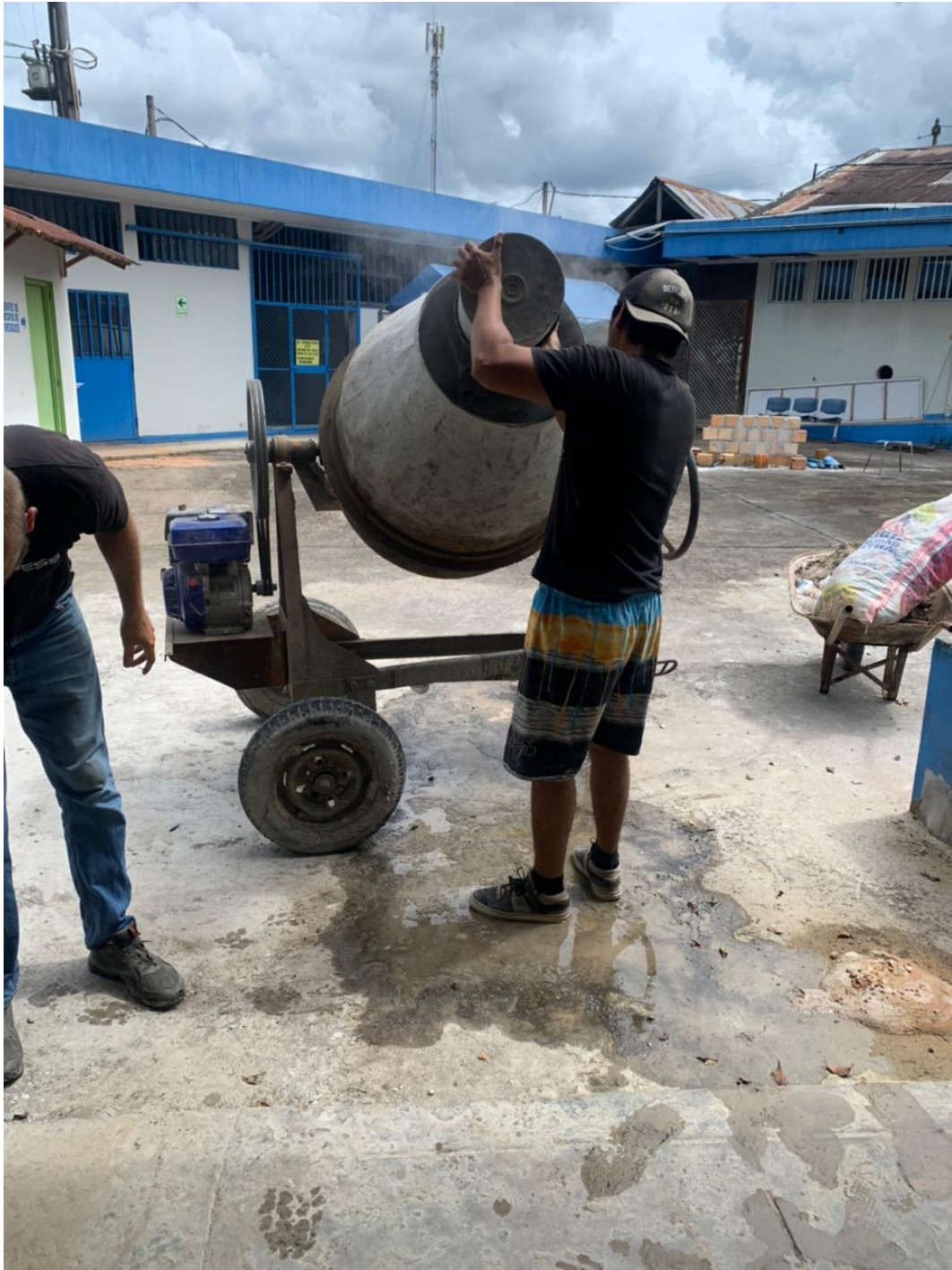
Preparación de la mezcla.
