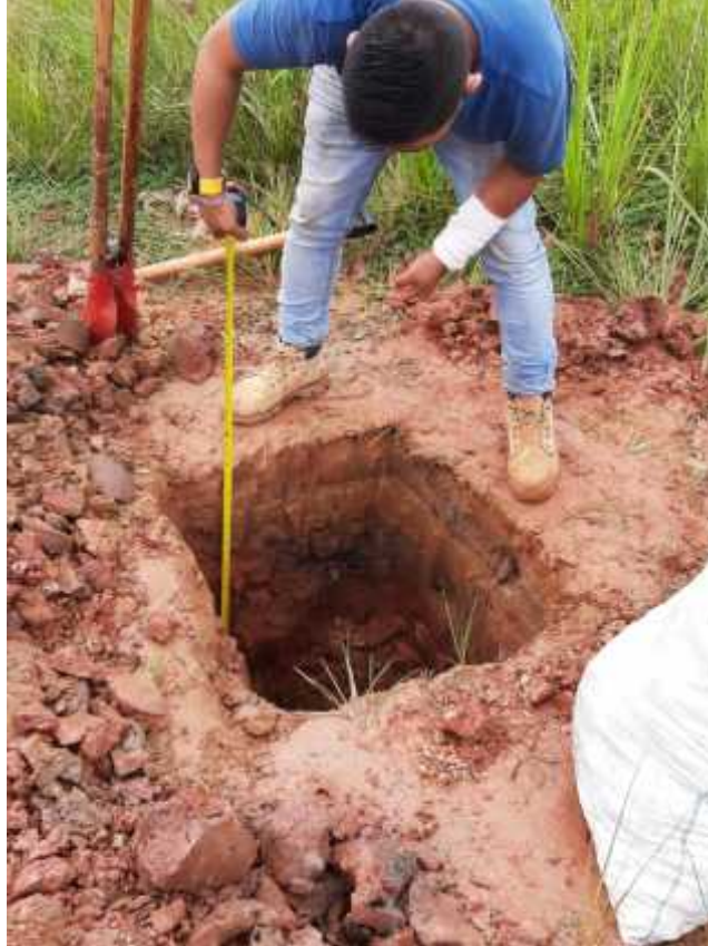
FOTO. 3 EXCAVACION DE CALICATA
