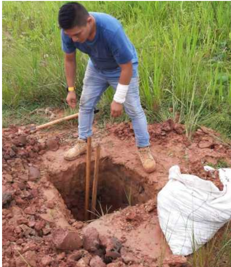
FOTO. 2 EXCAVACION DE CALICATA
