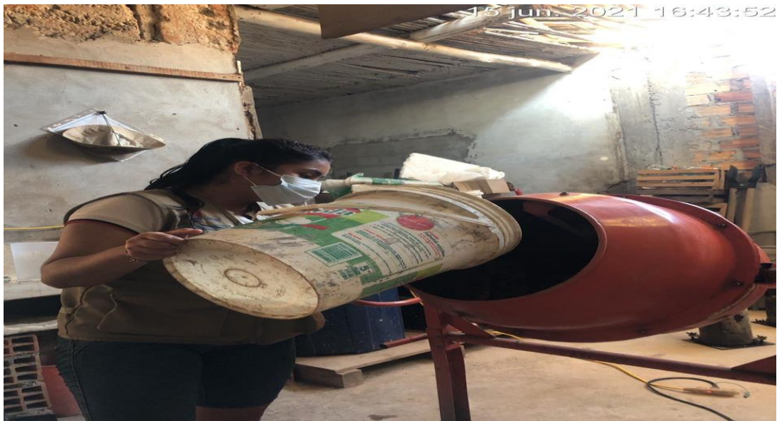
Fotografía N°12: Dosificación de los diseños de concreto.
