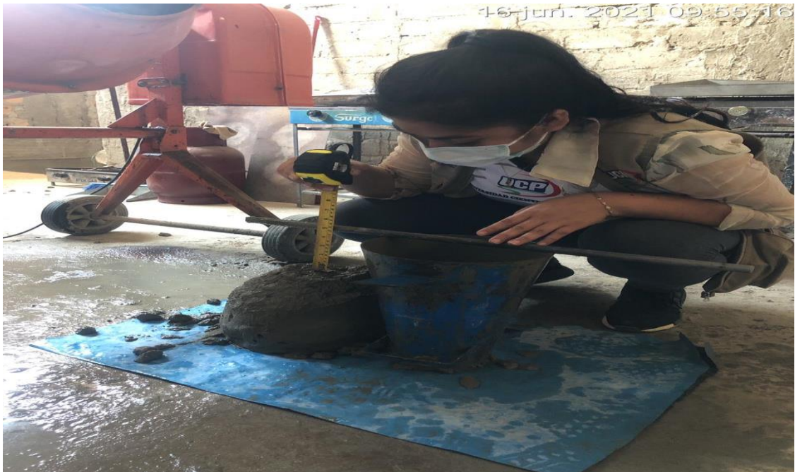
Fotografía N°14: Prueba de asentamiento para los diseños de Mezclas (Slump).
