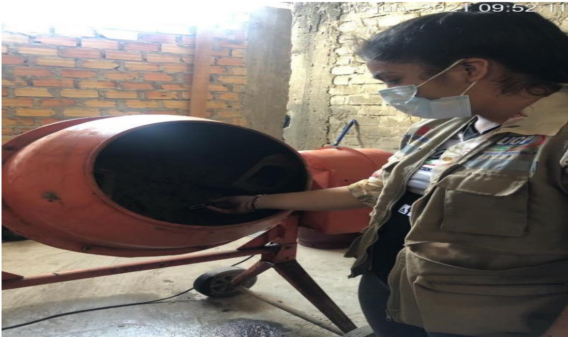
Fotografía N°13: Control de temperatura de los diseños de concreto.
