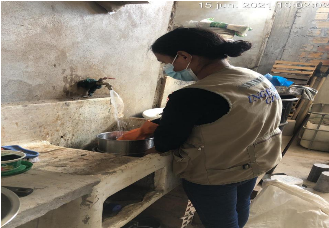
Fotografía N°3: Se puede apreciar el lavado del agregado.
