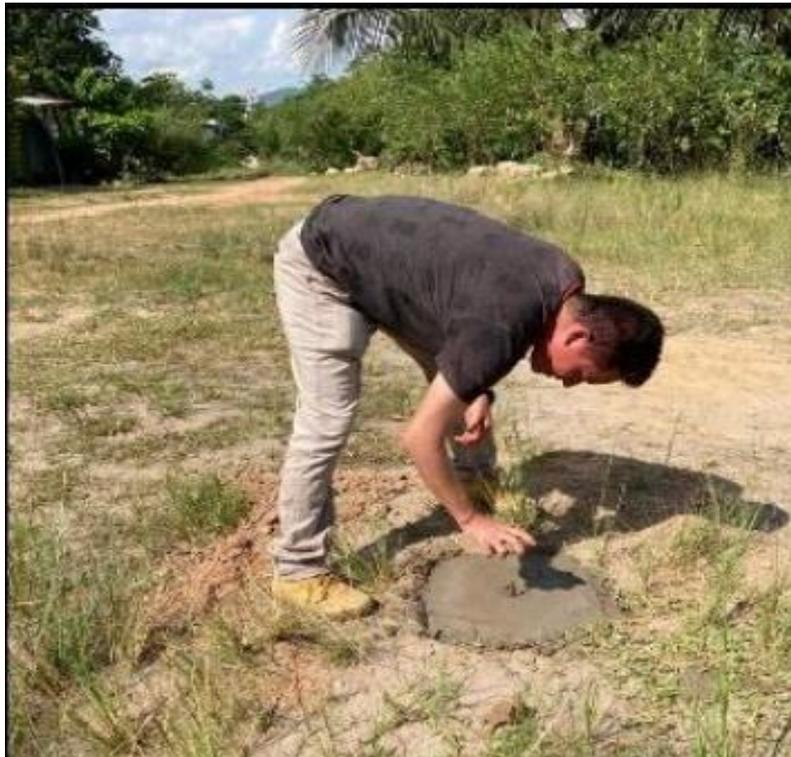
Figura 21: Excavación para monumentación de Punto Geodésico
