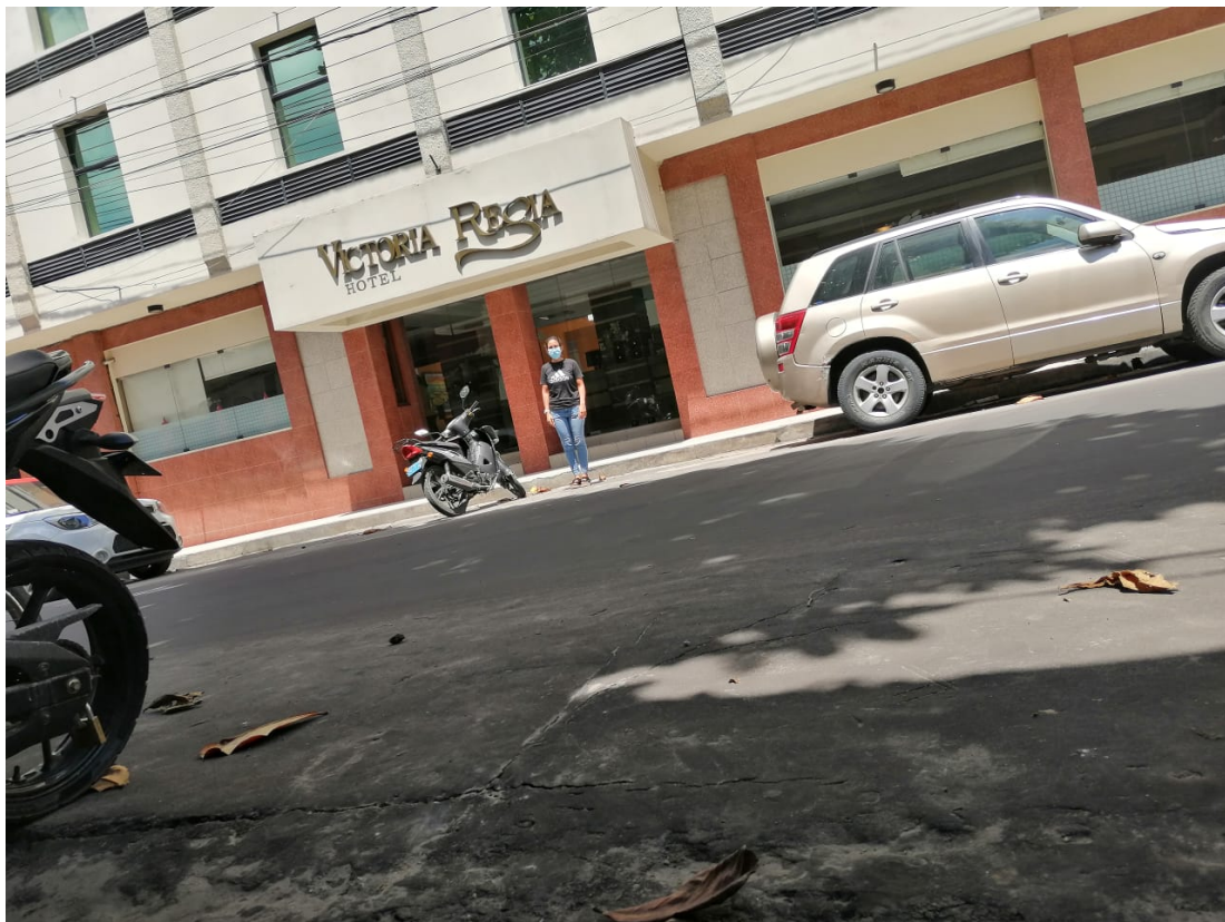
Vista de ingreso y sin rampa en el hotel Victoria Regia.
