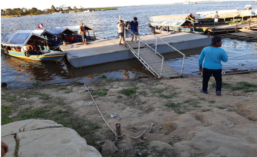
Rampa provisional de acceso a plataforma en embarcadero de Nanay, noviembre 2019
