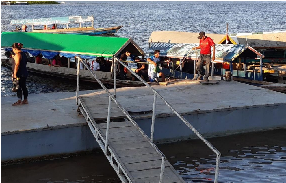
Plataforma provisional de ayuda a embarque en Nanay, noviembre 2019
