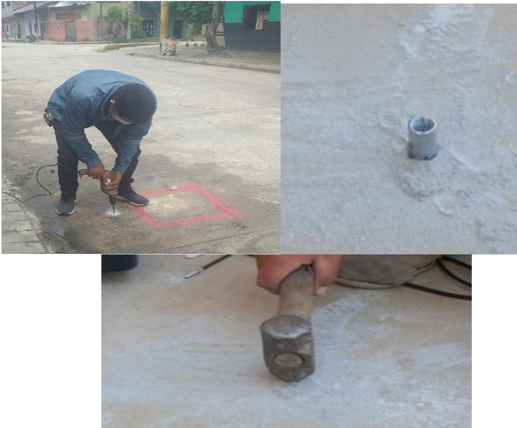
Imagen 11: Colocado de taco de expansión en el pavimento del E-19, realizado en la Cuadra 9 del Jr. Dos de Mayo.
