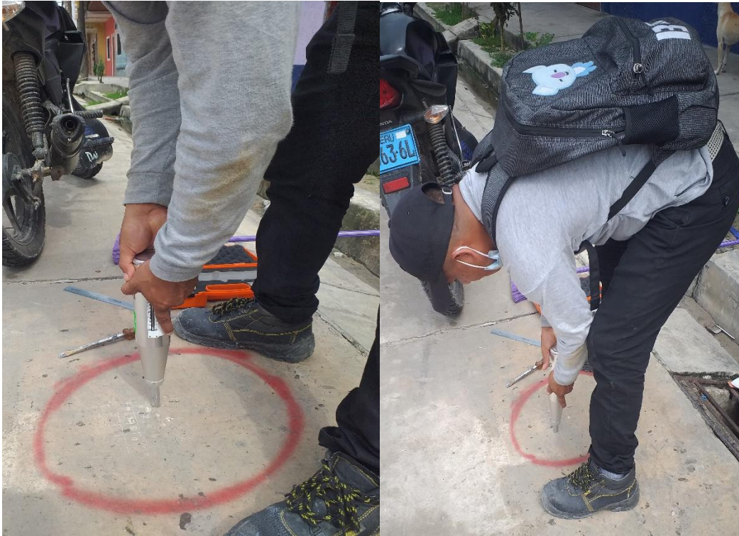
Imagen 9: Ensayo de Esclerometría E-13, realizado en la cuadra 7 del Jr. Dos de Mayo.
