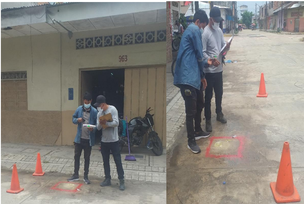
Imagen 10: Ensayo de Esclerometría E-19, realizado en la cuadra 9 del Jr. Dos de Mayo.
