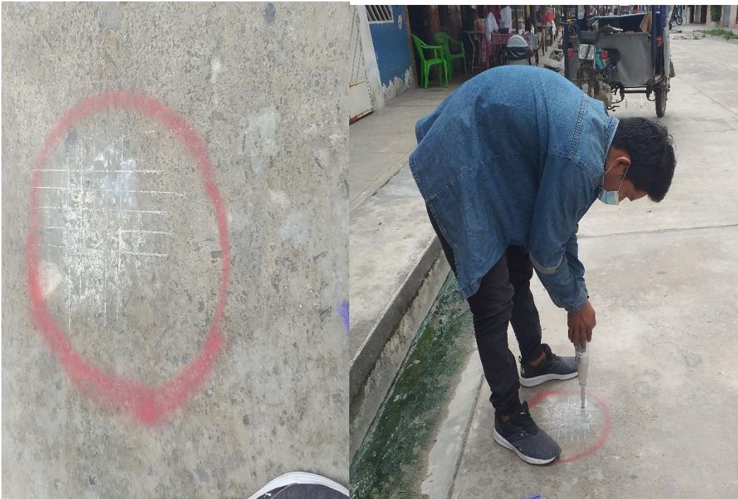
Imagen 8: Ensayo de Esclerometría del E-8, realizado en la cuadra 6 del Jr. Dos de Mayo.
