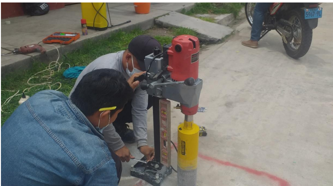
Imagen 12: Instalación del equipo sonda provista de brocas diamantadas, provista de tanque de agua.
