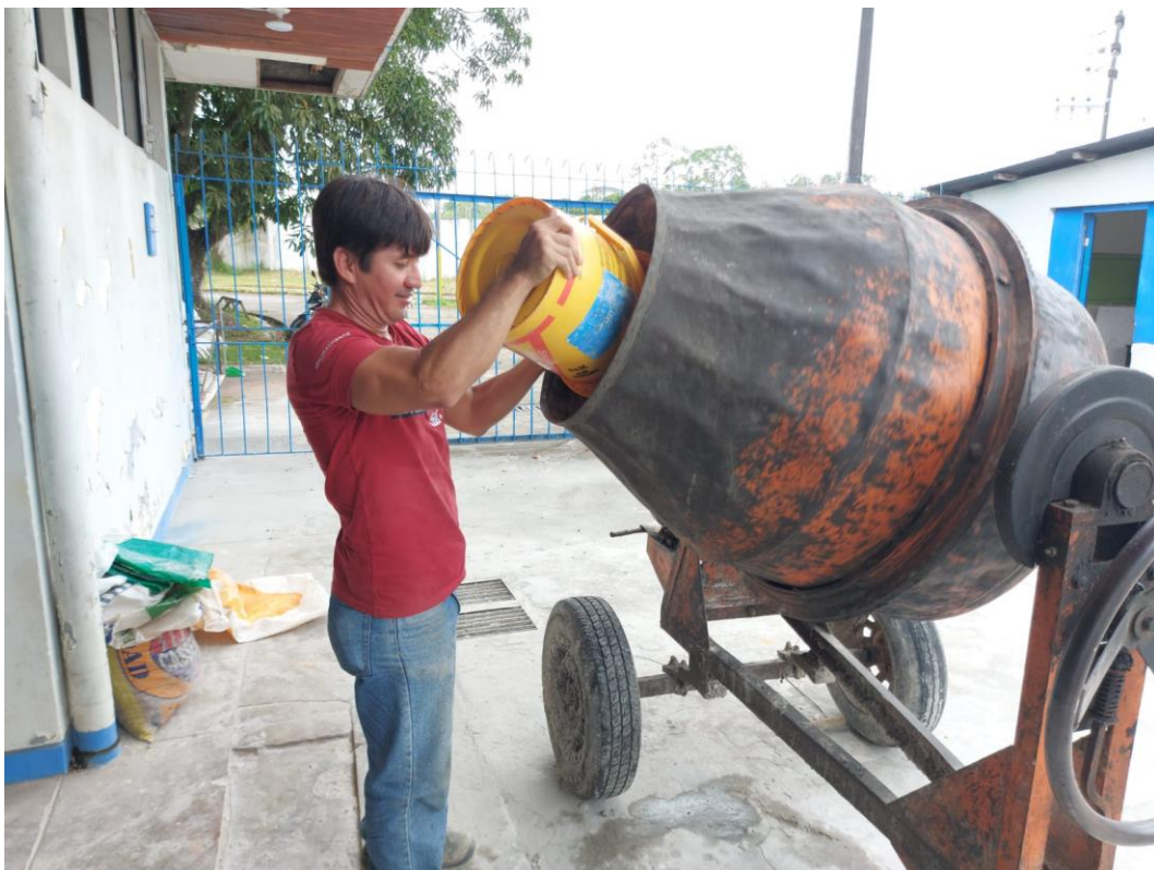
Colocación de materiales en la mezcladora.
