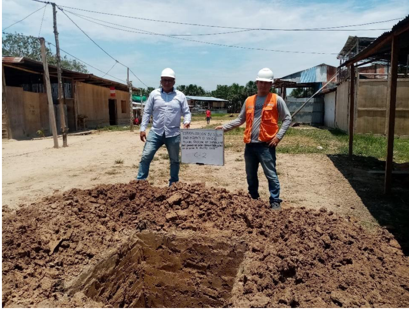
Imagen 6: Vista de la excavación de la calicata, para exploración de suelo a cielo abierto
