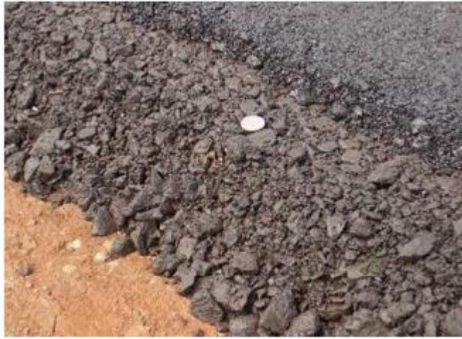
Figura 16: Sección de pavimento semirrígido con base estabilizada con concreto
