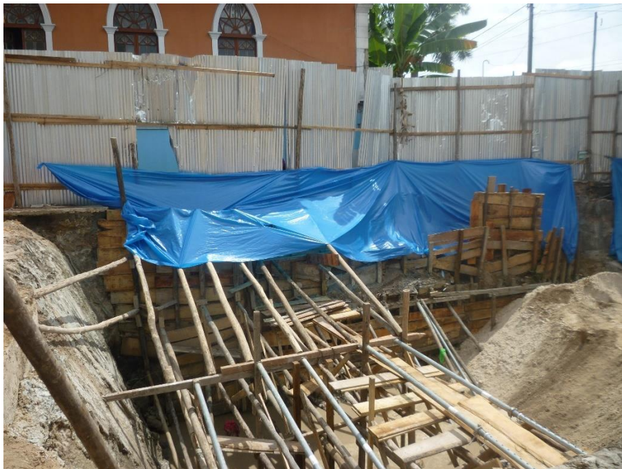
Foto 02 - Entibado utilizado inicialmente para la contención del talud.
