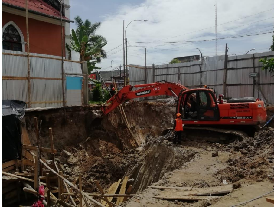
Foto 01 - Excavaciones iniciales, colindantes a la parroquia
