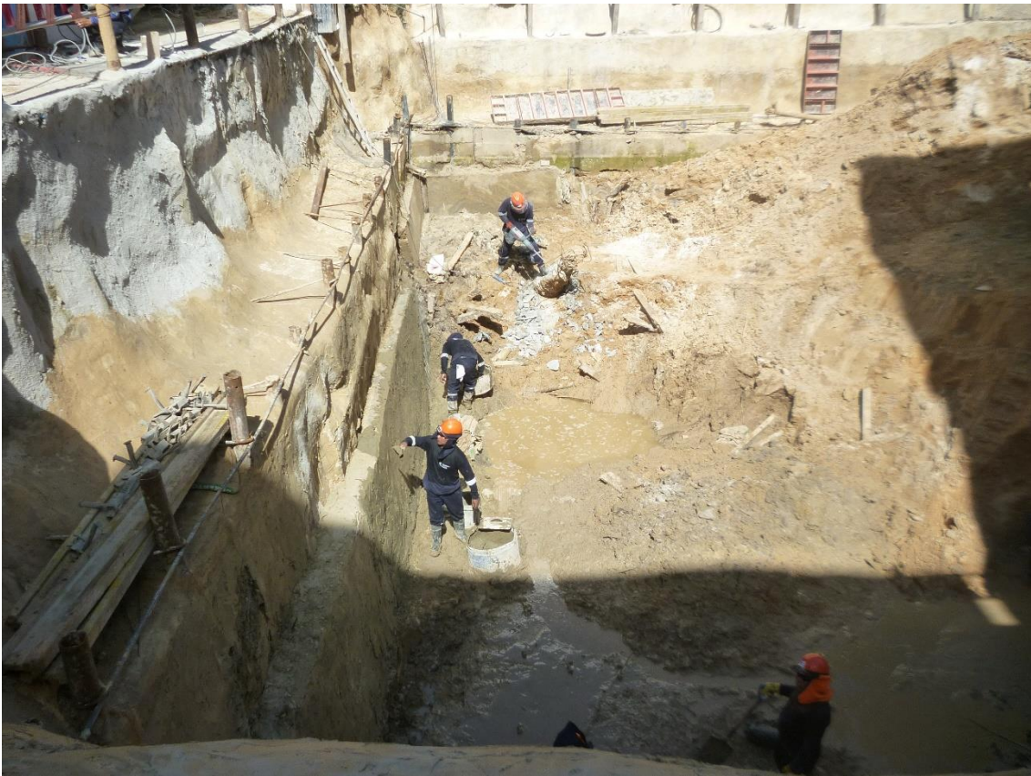
Foto 12 Plano de falla 3 estabilizado con el modelo propuesto.
