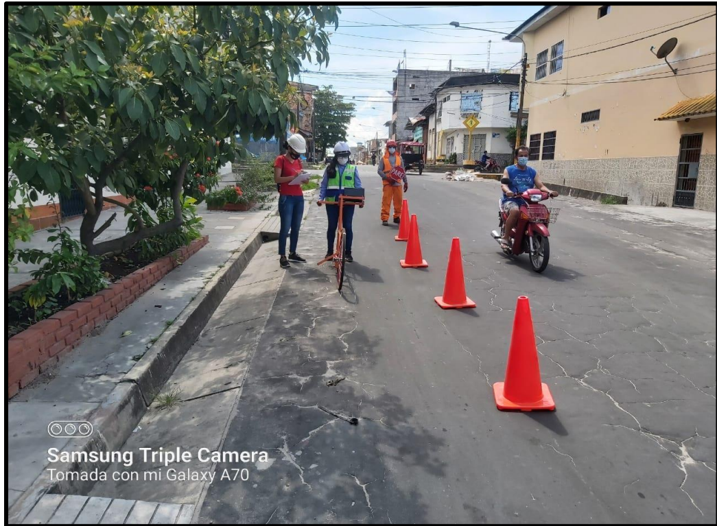
FOTO 01: VISTA PANORAMICA DE LA CALLE PABLO ROSSELL CUADRA 6, CARRIL 01 LADO DERECHO
