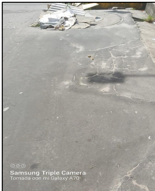
FOTO 05: VISTA DE FALLAS DEL PAVIMENTO DE LA CALLE PABLO ROSSELL CUADRA 6, CARRIL 02 LADO IZQUIERDO
