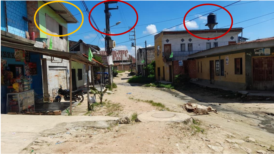
Figura 39. Jesús de Nazareth- Calle Los Pinos. En la foto se aprecia que en la zona de estudio tienen los servicios básicos de agua y luz independientes.
