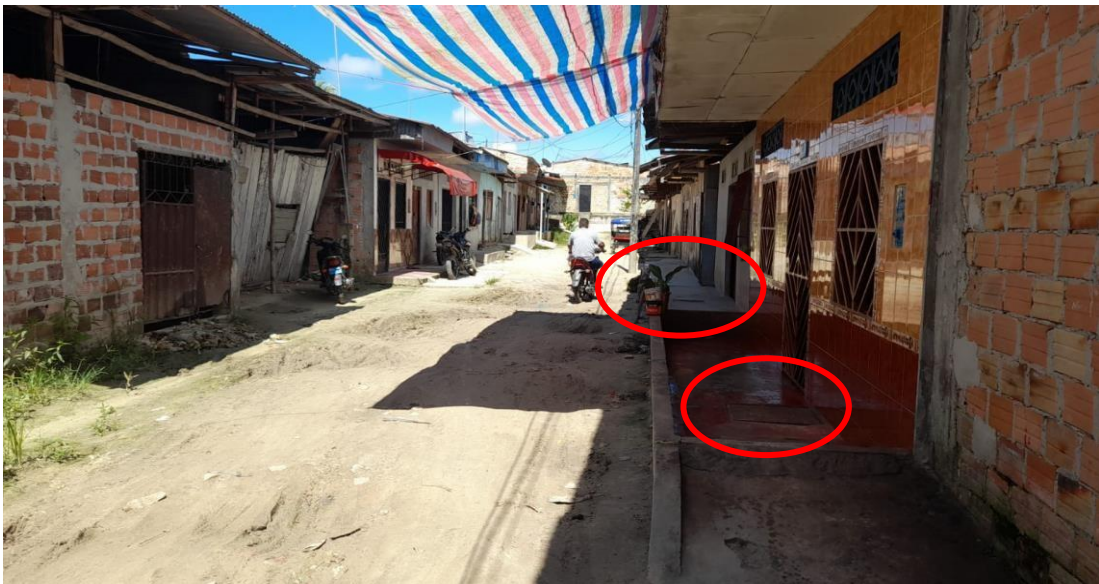
Figura 41. Jesús de Nazareth- Calle Los Pinos. Se observa deterioro de la vía, tiene fácil acceso, sin embargo, presenta zonas con almacenamiento de agua por lluvias.
