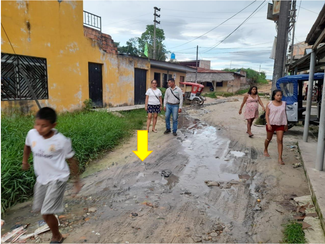
Figura 41. Jesús de Nazareth- Calle Los Pinos. Se observa deterioro de la vía, tiene fácil acceso, sin embargo, presenta zonas con almacenamiento de agua por lluvias.
