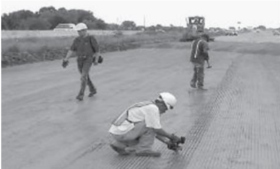
Ilustración 15: Geomallas alineadas y tensada
