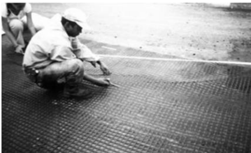
Ilustración 14: Corrección de arrugas
