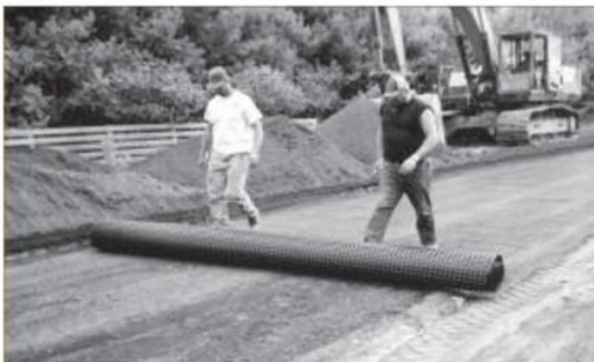
Ilustración 12: Colocación y tendido de la geomalla
