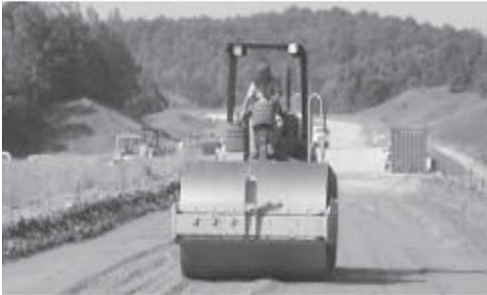
Ilustración 17: Procedimiento de compactación tradicional
