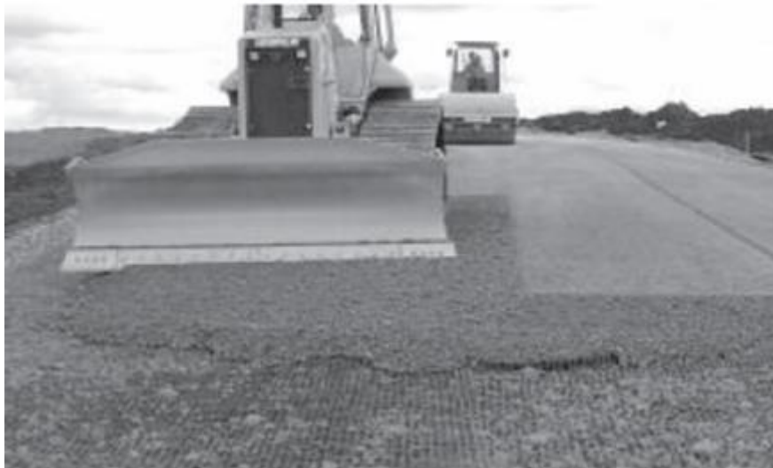
Ilustración 16: Tendido de material sobre la geomalla
