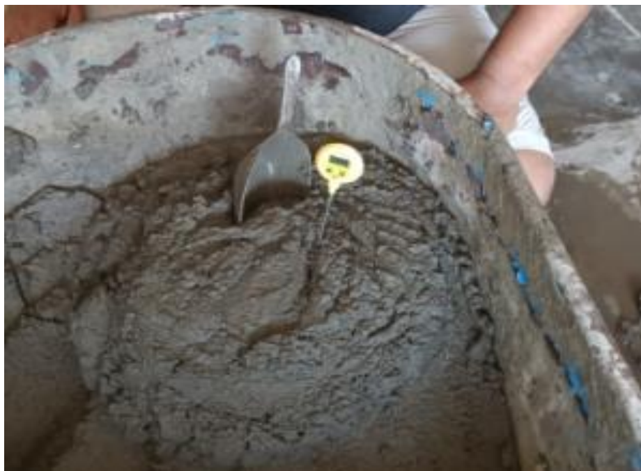
Fotografía 12: Medición de temperatura de la mezcla.
