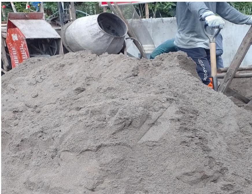
Fotografía 1: Utilización de la arena del rio Amazonas en concretos cemento – arena en la obra “MEJORAMIENTO DE LA VIA DE ACCESO AL AA.HH. CIUDAD JARDIN, AA.HH. AMPLIACIÓN CIUDAD JARDIN Y CASERIO CABO LOPEZ, DISTRITO DE BELÉN – MAYNAS – LORETO”.
