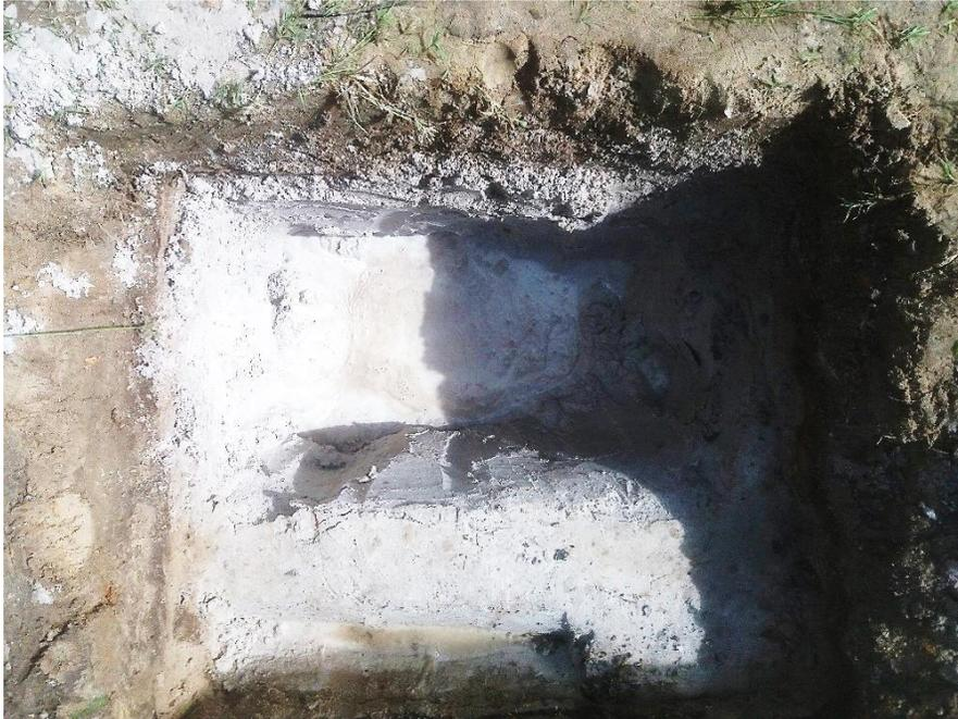
**Figura 15. Filtración de agua en calicata C-1**
