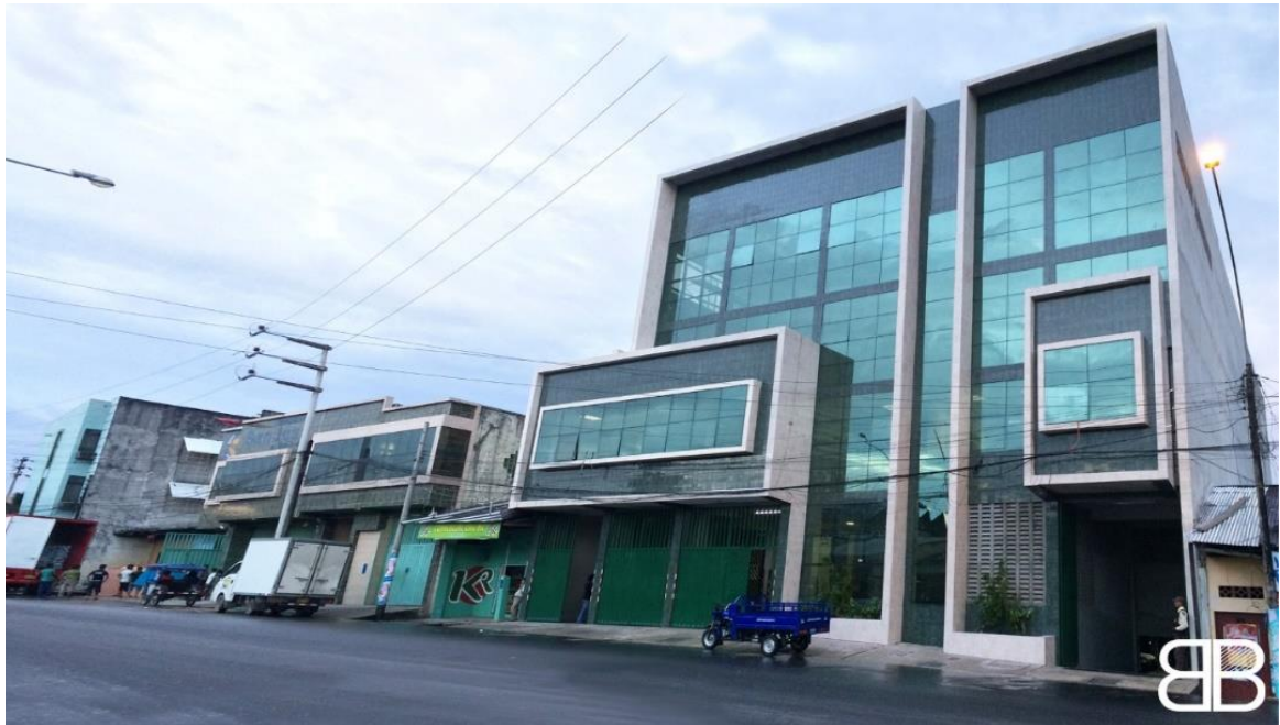
Gráfico N° 06: Edificio Comercializadora San Juan
