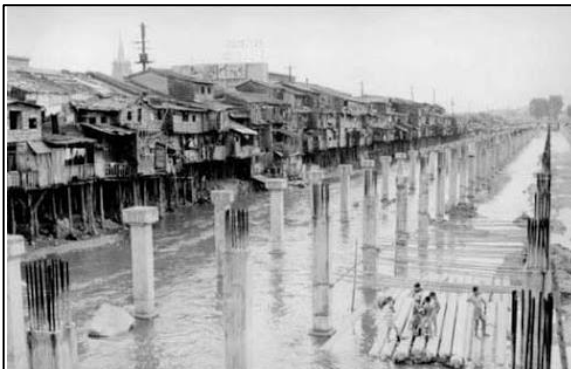
FIGURA 12. OBRAS DE CUBRICION DEL RIO FUENTE: ANONIMA
