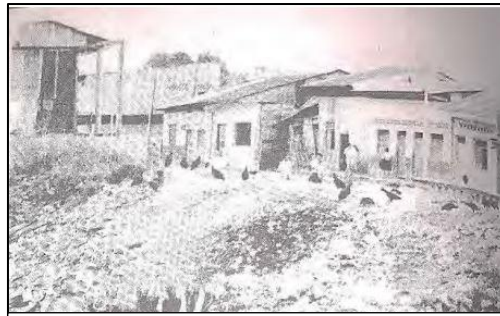
FIGURA 6. ESCENARIO DE ANTAÑO DE LA QUEBRADA SACHACHORRO FUENTE: ARCHIVO BENDAYAN.
