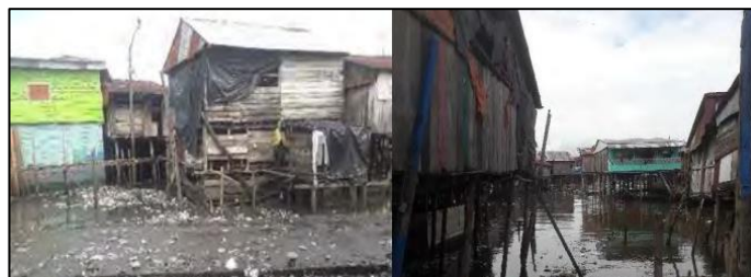
FIGURA 38. ESTADO ACTUAL DE LA QUEBRADA Y VIVIENDAS FUENTE: ELABORACION PROPIA
