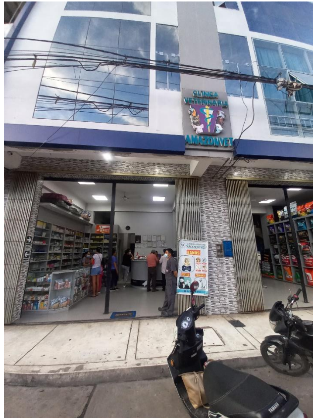
Figura 11 Fachada de clínica veterinaria. Fuente: Foto propia
