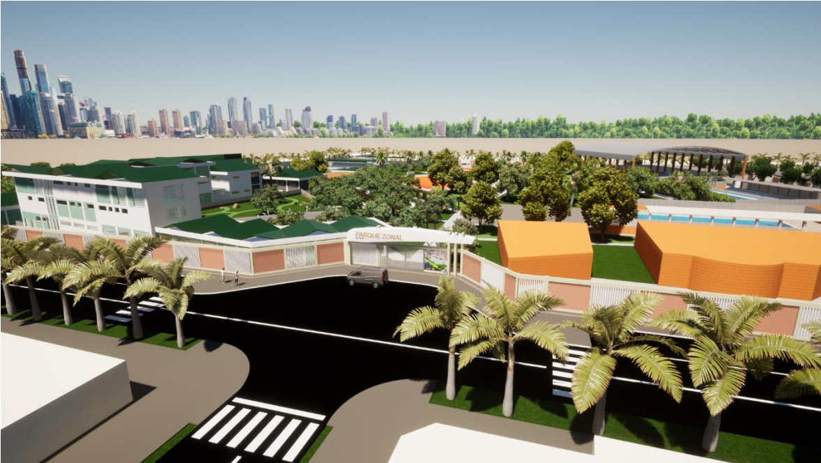
Vista exterior de la Jr. Yavarí con referencia al proyecto.
