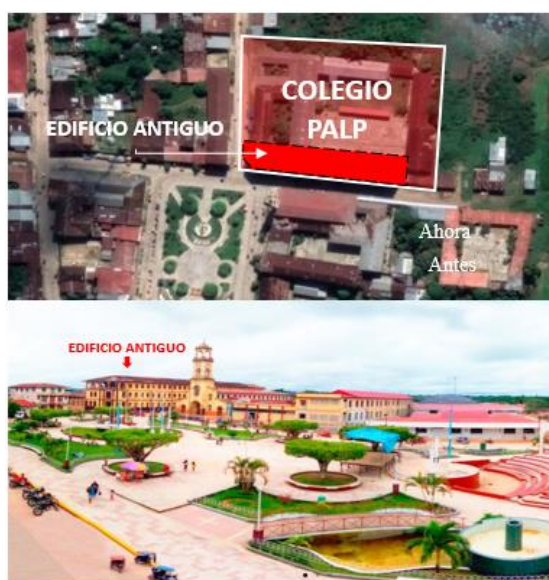
Figura N° 16. Ubicación del edificio de valor cultural
