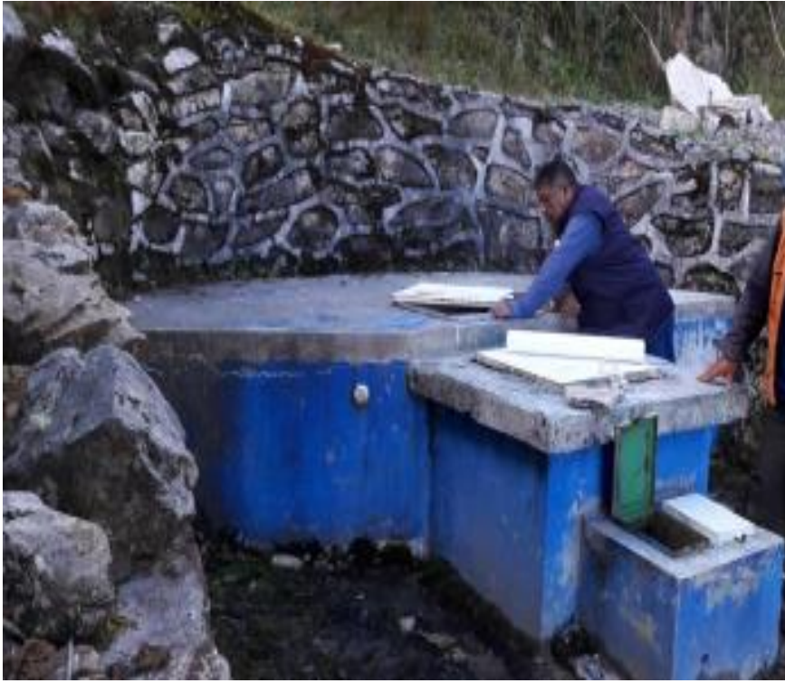
Figura 6. Reservorio de agua potable de la localidad de Cajén
