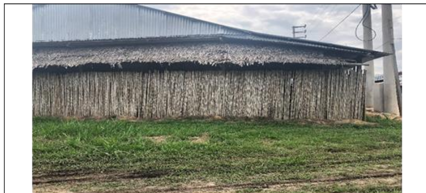
Figura N° 21: La caña brava es utilizada como cercas para la delimitación de sus terrenos en la vivienda.
