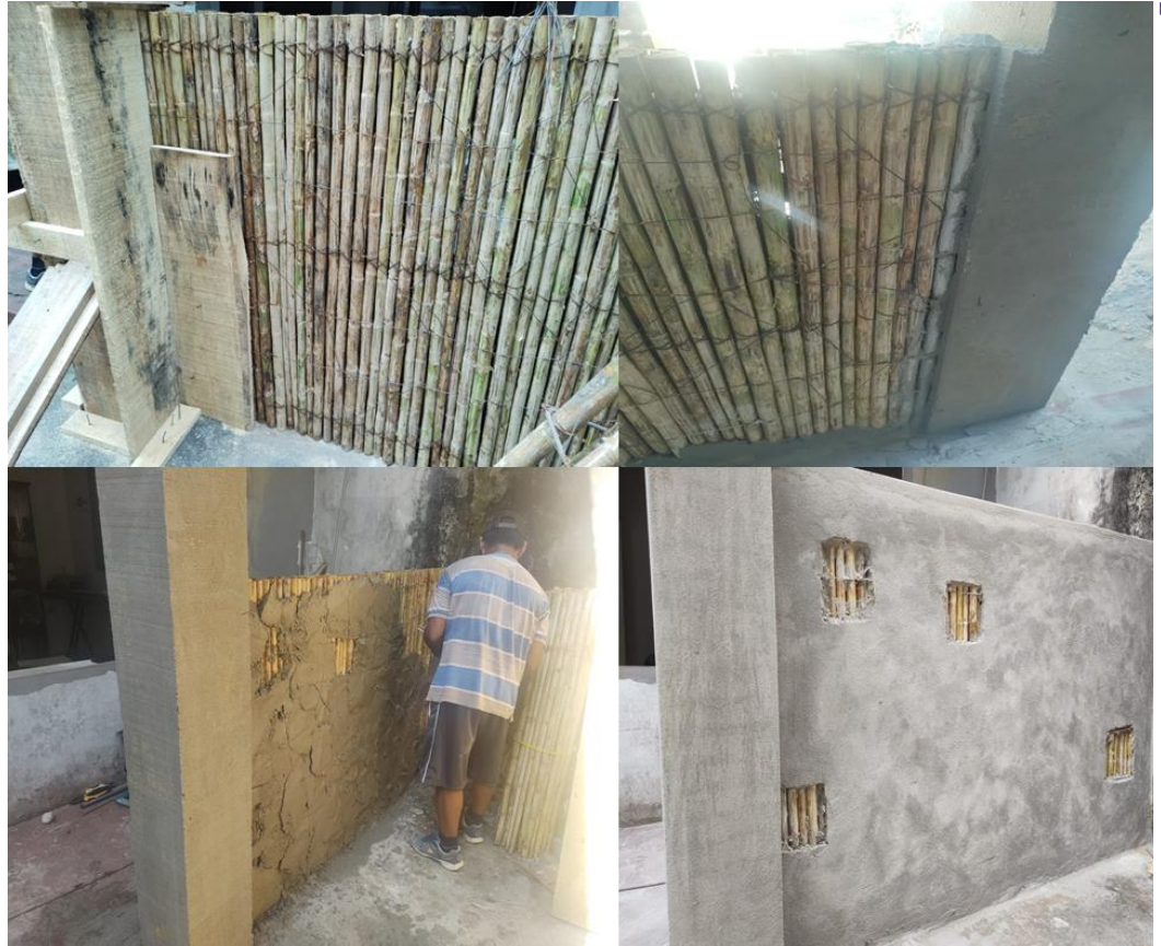
Figura N° 28: Elaboración del prototipo con la caña brava
