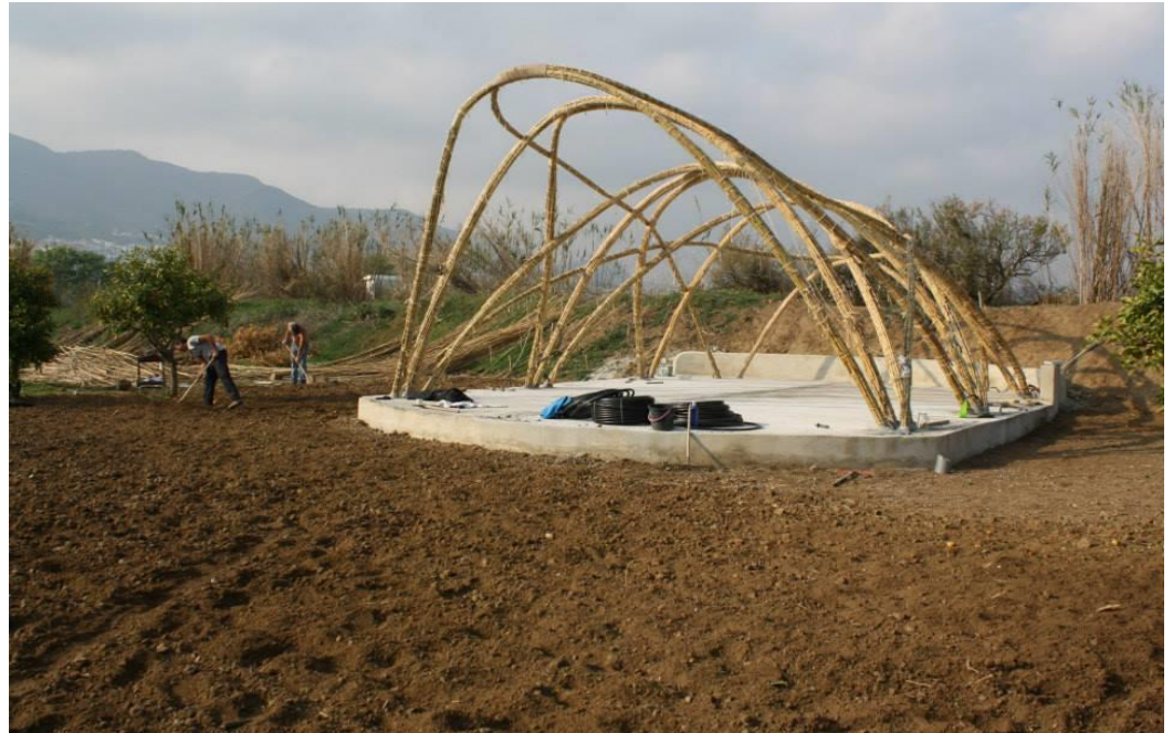
Figura N° 10: Foto del procedimiento constructivo de la cobertura con caña brava. (31)
