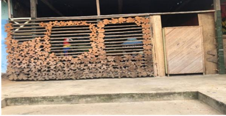
Figura N° 25: Se aprecia el uso de otros materiales como el caso de un troco de árbol cortado y utilizado como decoración en la fachada.
