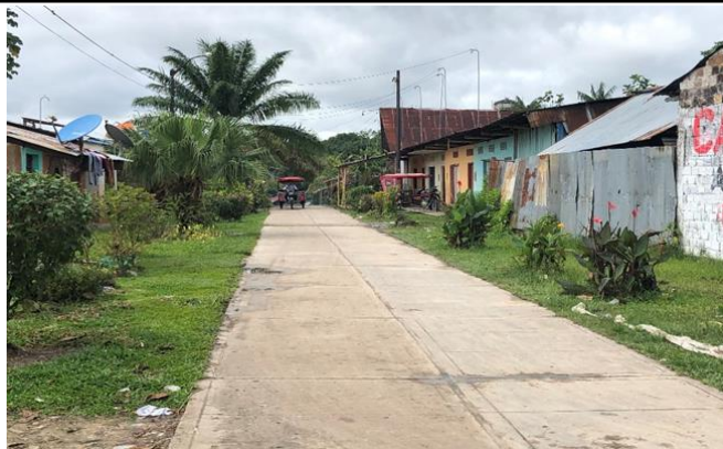
Figura N° 20: Veredas peatonales, que sirven como camino de los pobladores para desplazarse y traslado de las moviidades FUENTE: Grupo de Tesis
