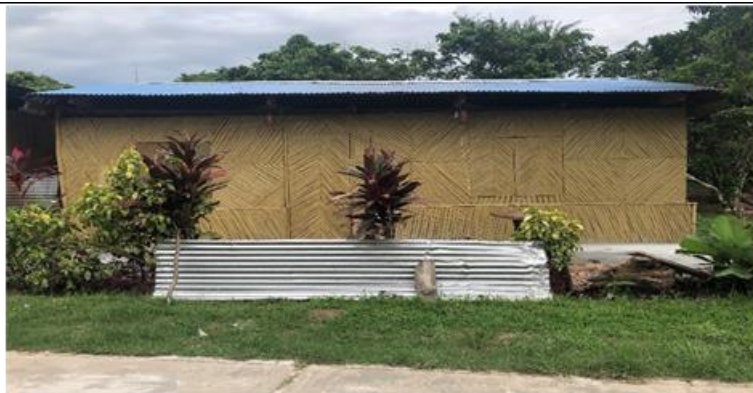
Figura N° 24: El uso total de la caña brava en una vivienda desde las paredes, puertas y ventanas.
