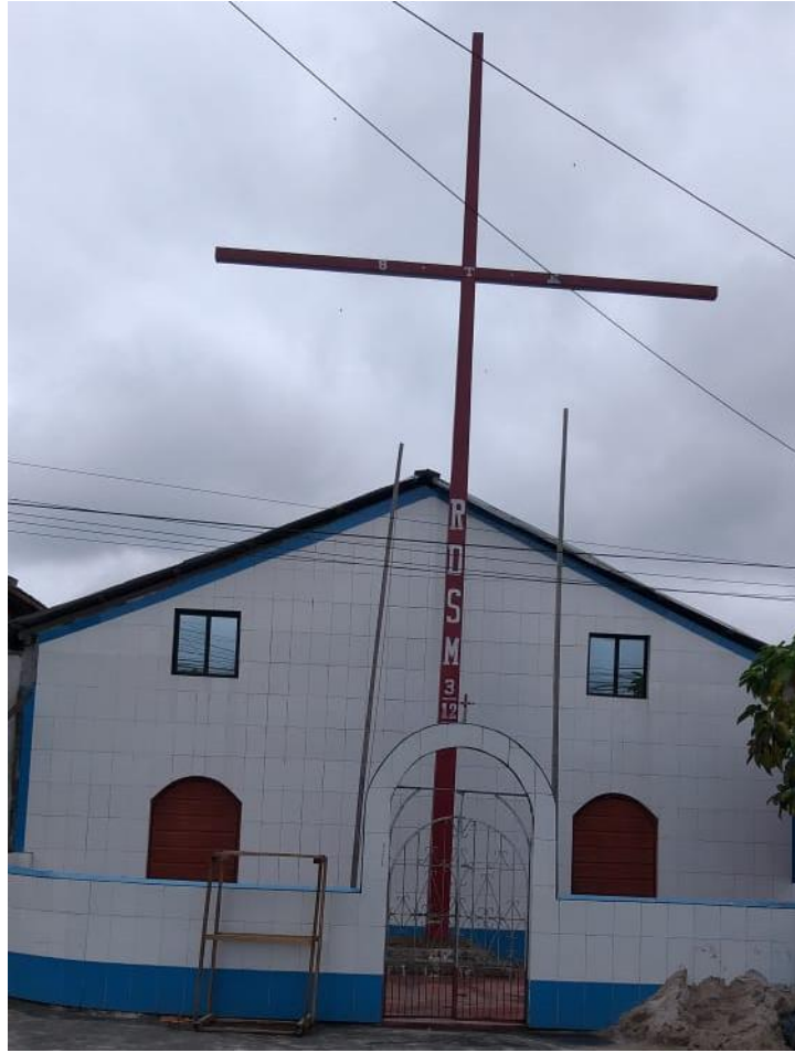
Figura 8: Iglesia de los hermanos de la Cruz de Moronacocha. Fuente: Elaboración Propia.
