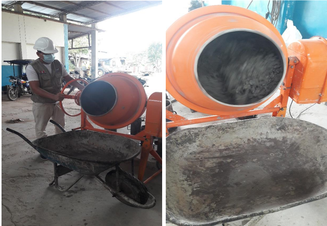
Figura 33: preparación de la mezcla
