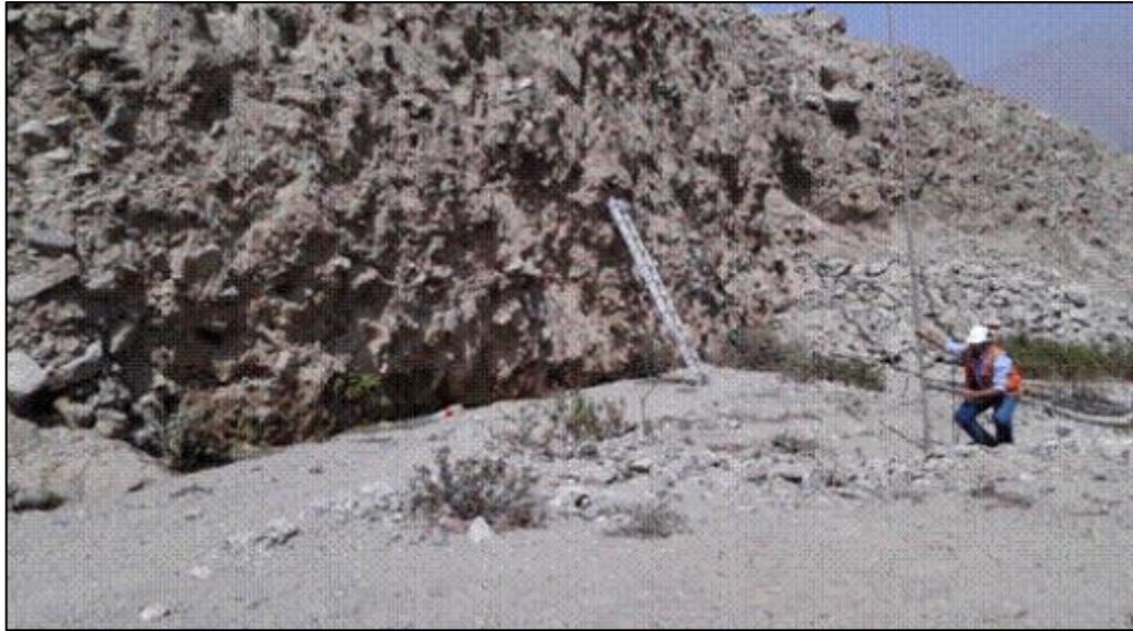
Figura 23: Marcación de puntos de los postes con wincha y pintura
