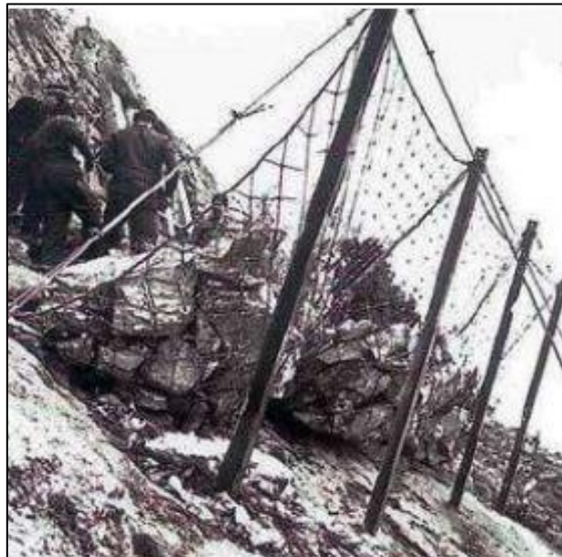
Figura 18: Sujeción de redes en las barreras
