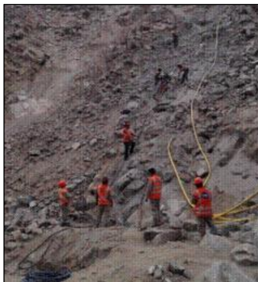
Figura 24: Marcado de puntos para perforación
