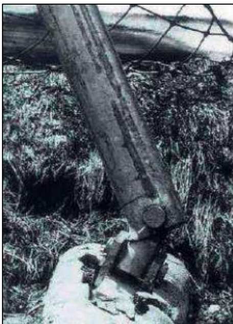
Figura 20: Apoyo articulado en la base de los postes
