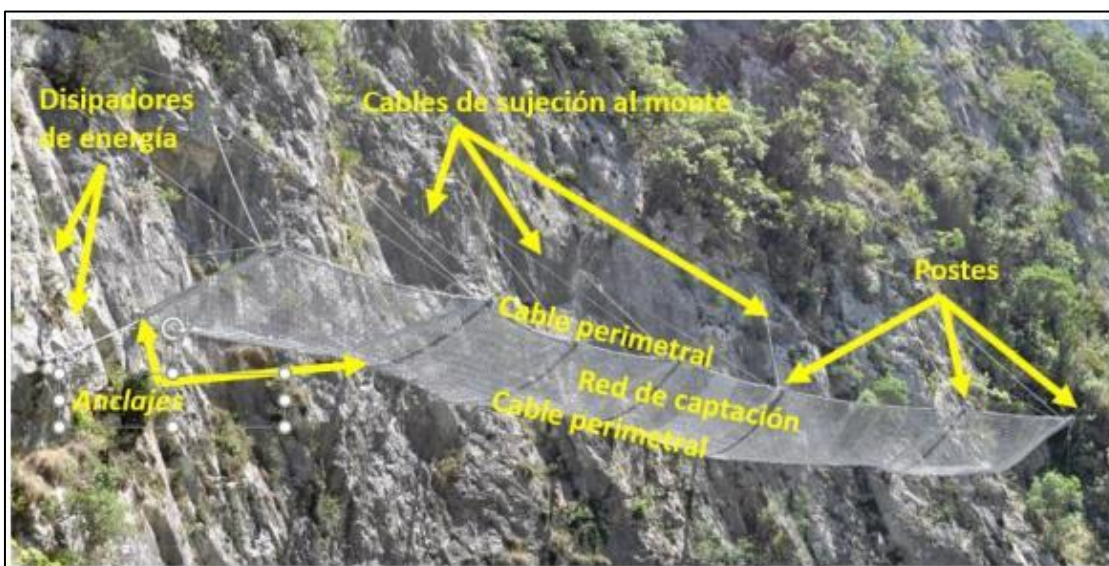
Figura 1: Partes de barreras dinámicas
