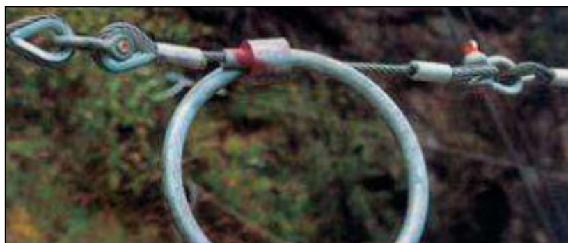
Figura 16: Sistema de frenado a base de anillos
