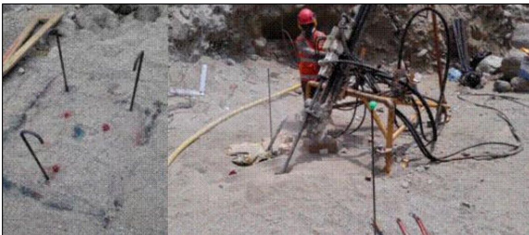
Figura 25: Inicio de perforación
