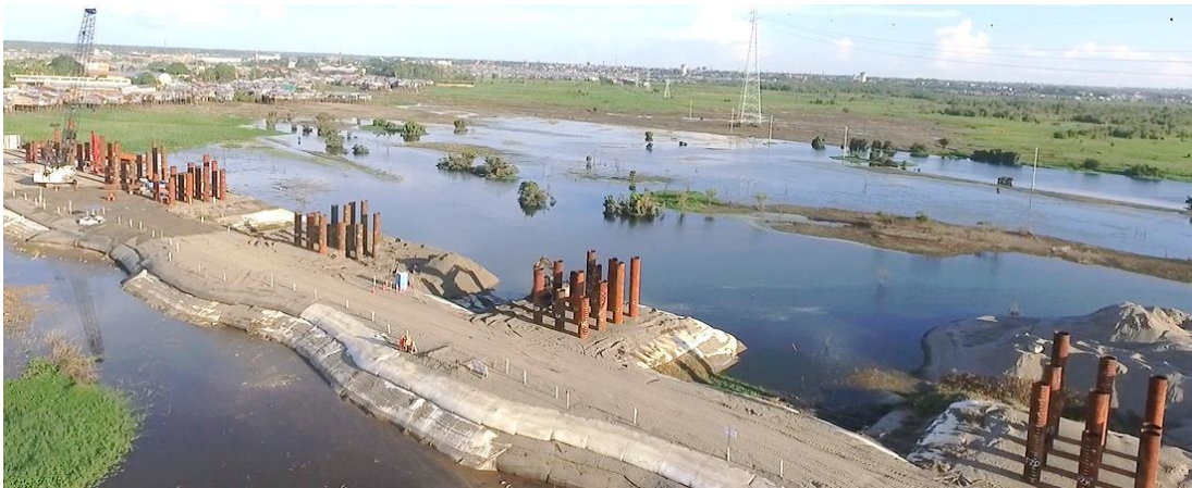
Figura 10. Hincado de Pilotes Metálicos
