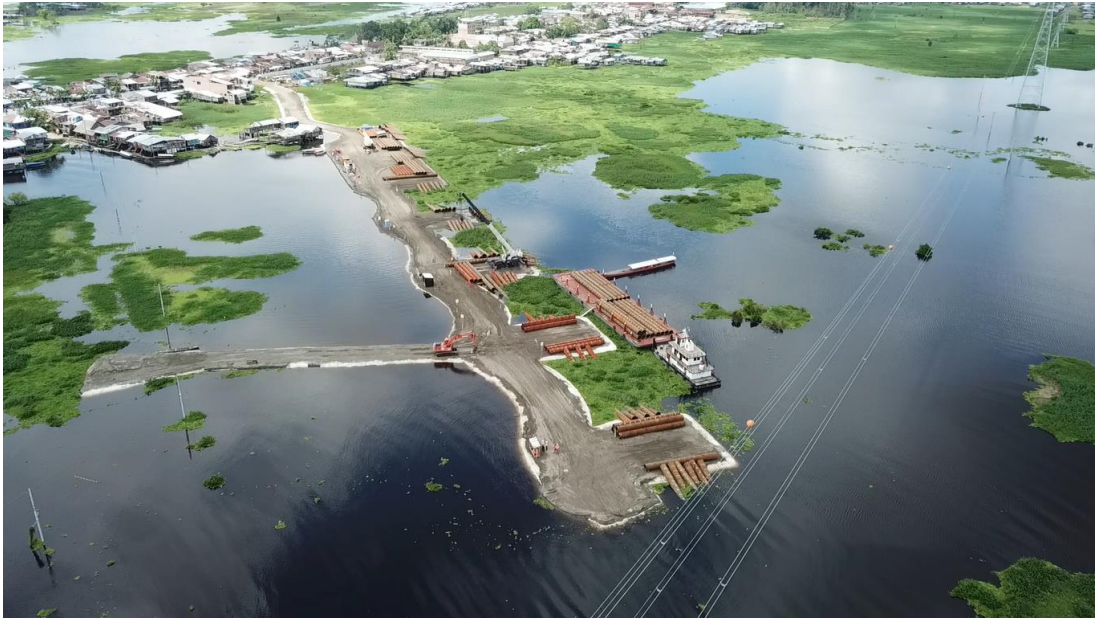
Figura 8. Camino Provisional de construcción del Puente de Nanay
