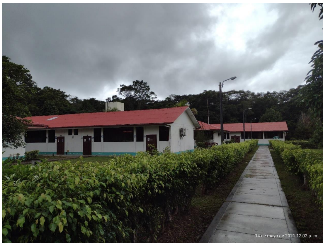
Foto 156: Exteriores de la Facultad de Farmacia y Bioquímica. (Fuente propia)
