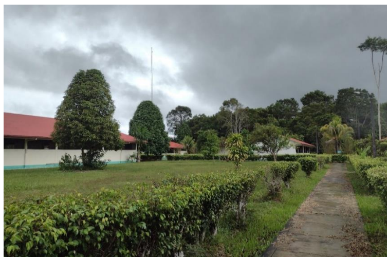
Foto 17 y 18: Instalaciones de la facultad de farmacia (Fuente propia)
