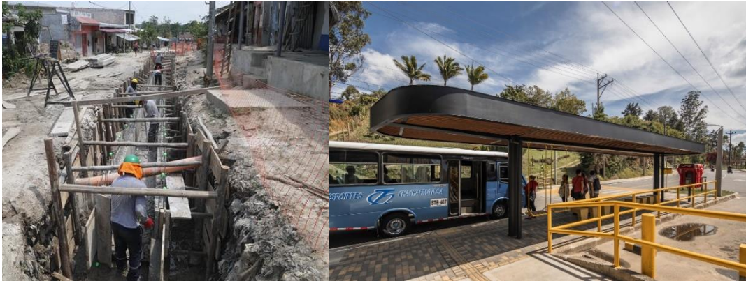
-Foto 56, izquierda: Obras de saneamiento en Nauta (Fuente: Gobierno del Perú). Foto 57, derecha: Parada de transporte público masivo en Rionegro, Colombia (Fuente: Alejandro Arango)
