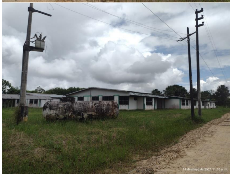
Foto 10 y 11: Zona administrativa (Fuente propia)
