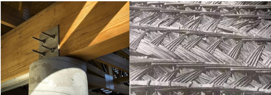
Foto 233, 234: Estructura de madera y acero para techo (Fuente: perfectaidea.com). Crizneja de irapay tejida en cadena.
