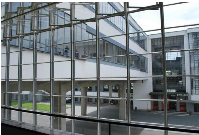
Foto 88: El muro cortina es un sistema de cerramiento muy usado en el edificio. (Fuente: tripadvisor)
