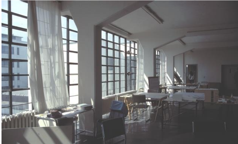
Foto 87: Interior de un taller. Se usa el sistema aporticado en la estructura. (Fuente: López, Leandro)
