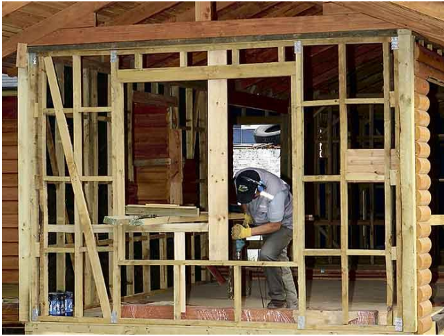
Foto 235: Construcción de una tabiquería de madera. (Fuente: lacuarta.com)
