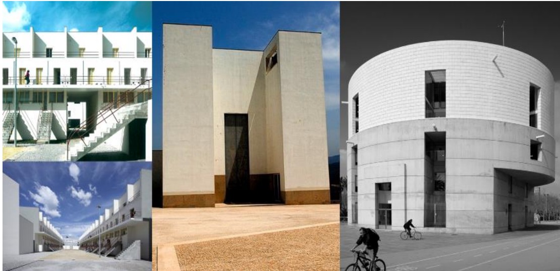
IMAGEN 25. Vivienda Social en Porto (1973), Iglesia Santa María, Portugal (1990), y Estación de meteorología, Barcelona (1992).
