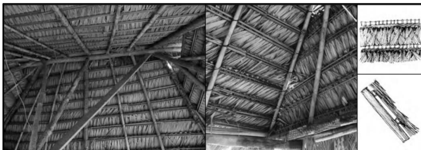
IMAGEN 34. Estructura de techo tradicional.
