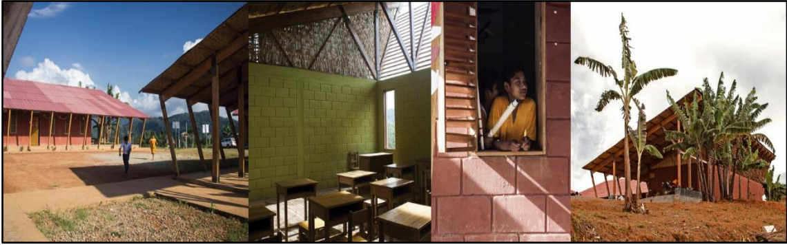
IMAGEN 55. Utilización de materiales vernáculos y modernos (Referencia nacional 1)
