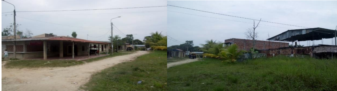
IMAGEN 86. Calle Navarro Cauper/ Pasaje Ulises. Fuente: Elaboración propia.
