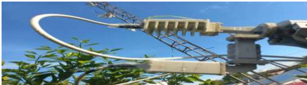
Figuras 6: Cableado y Conectorizado
