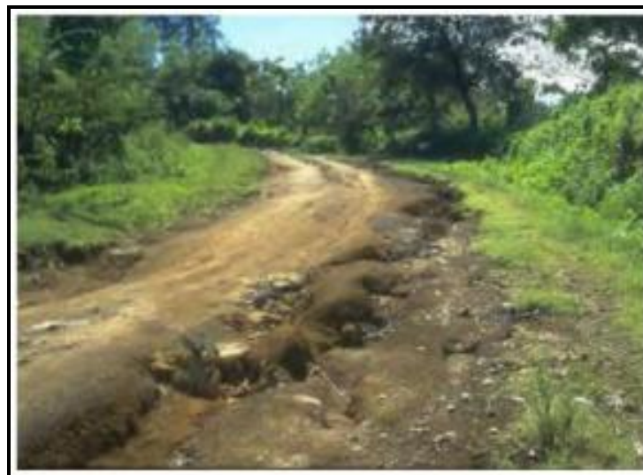
Ilustración 6: Drenaje inadecuado
