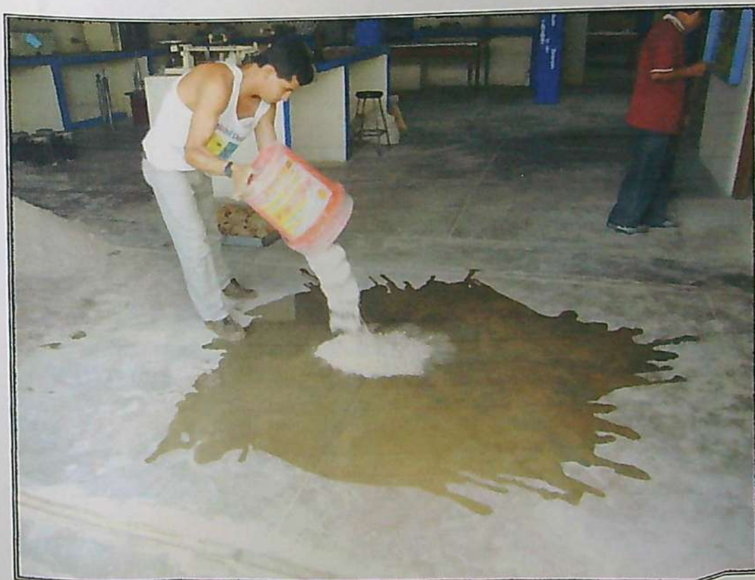
FOTO N° 4 Preparación del área de trabajo dentro del laboratorio.
