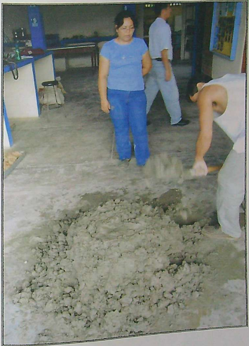
FOTO N° 6 Batido manual de la mezcla.
