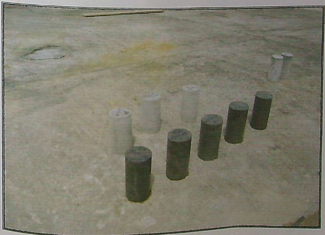
FOTO N° 20 Secado de las probetas para posterior ensayo de verificación de la resistencia.
