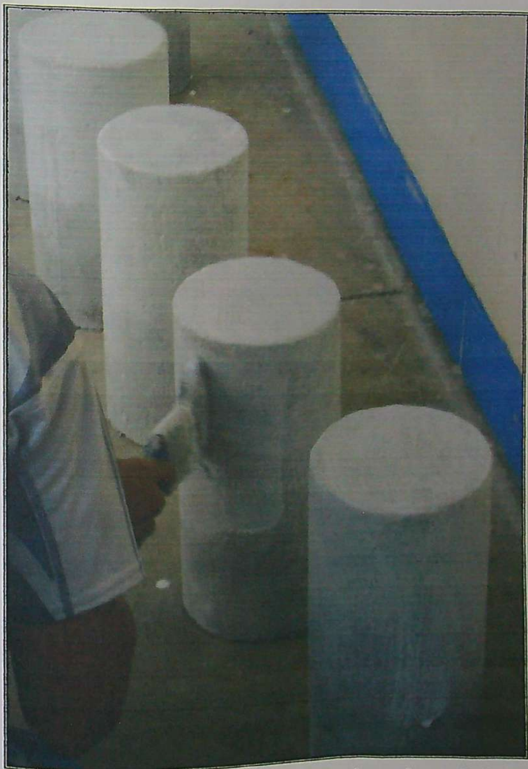
FOTO N° 18 Aplicación de la segunda capa de membrana plástica.
