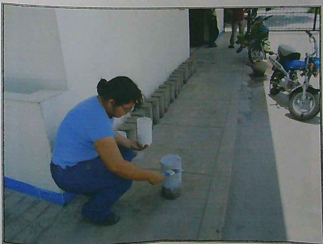
FOTO N° 17 Aplicación de la primera capa de membrana plástica.
