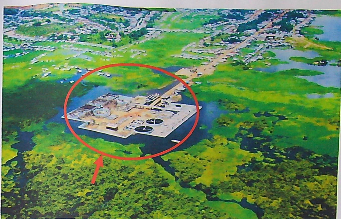
FOTO N° 09: La programación del cronograma de ejecución de obra no previno época de creciente de los ríos, y se observa que la Planta de Tratamiento de Aguas Residuales se inundo al momento de la ejecución.
