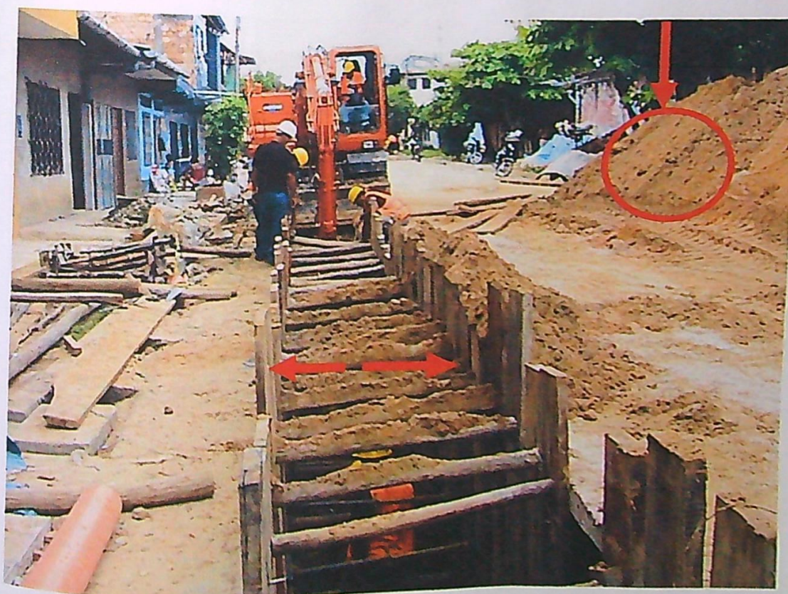
FOTO N° 14: La forma correcta de apuntalamiento y/o entibado al momento de la excavación, y el material excedente respetando la distancia entre la zanja y el acopio.
