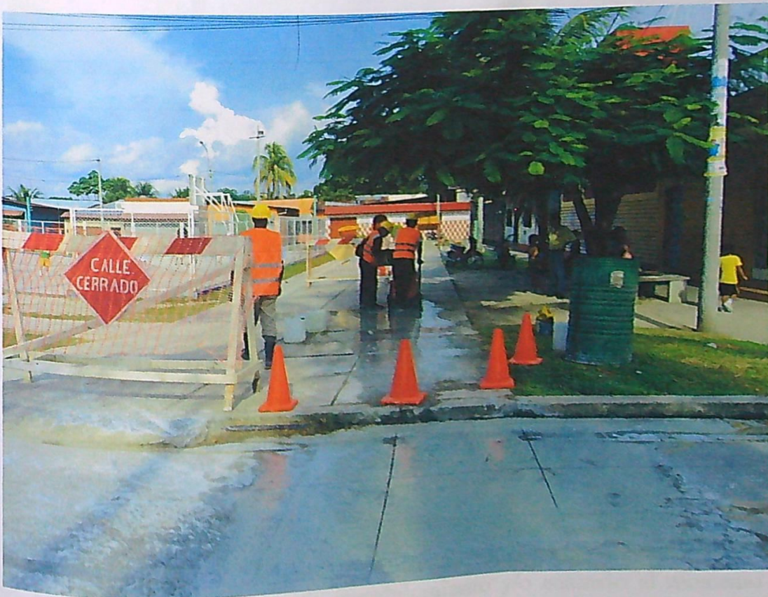
FOTO N° 12: Carteles de desvíos, tranqueras y conos que se utiliza para una buena seguridad en obra.
