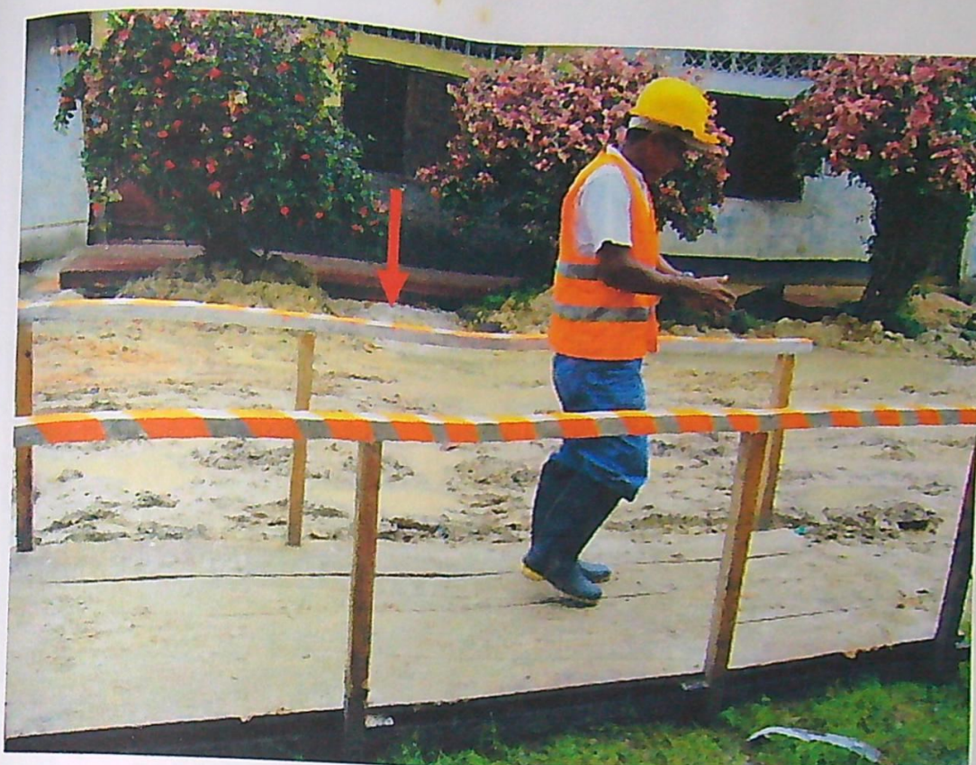
FOTO N° 13: Puentes de Madera que se coloca en forma transversal en la zanja para pase del peaton.
