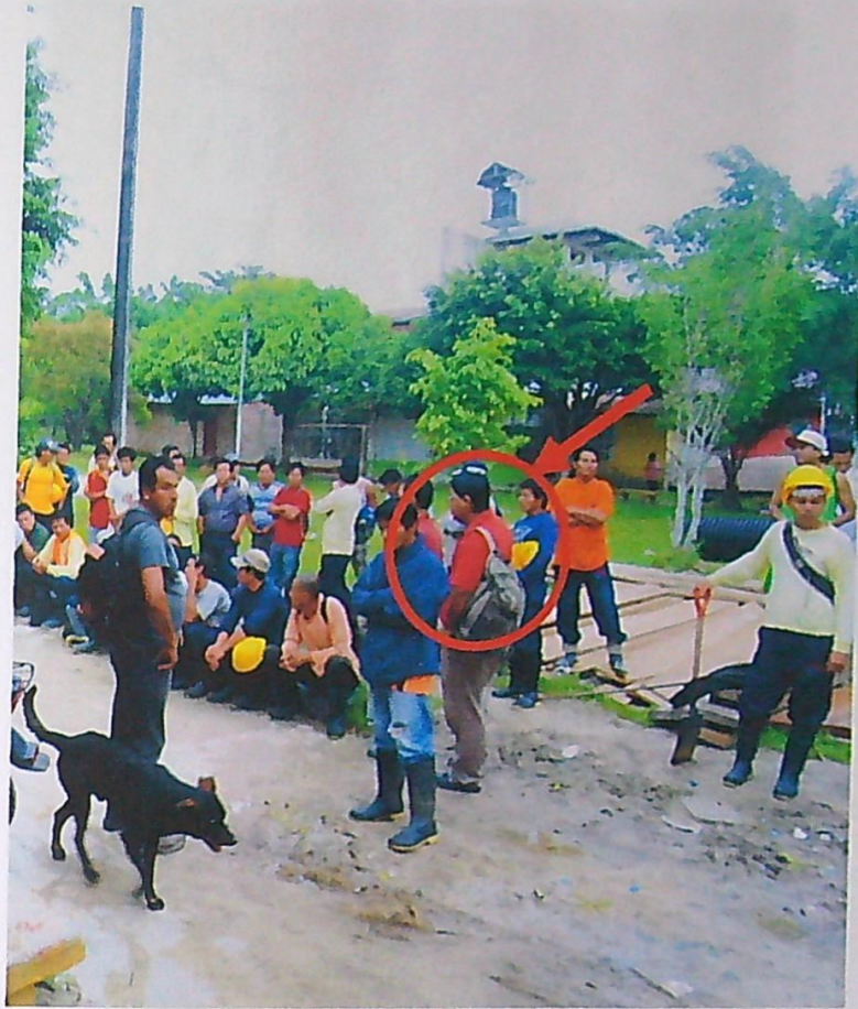
FOTO N° 01: Responsable de Seguridad y Salud hacienda charla de 5 minutos en condiciones inadecuadas.
