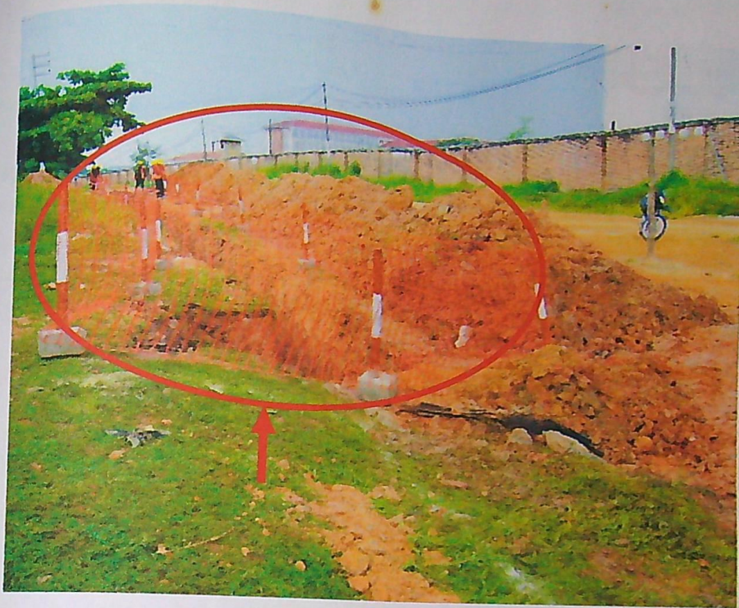
FOTO N° 15: El área de ejecución con mallas de seguridad para prevención de riesgos.
