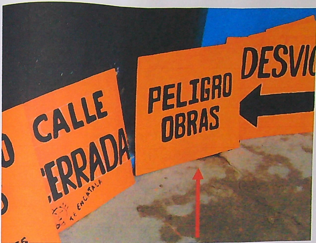
FOTO N° 11: Carteles de desvíos que se utiliza para una buena seguridad en obra.
