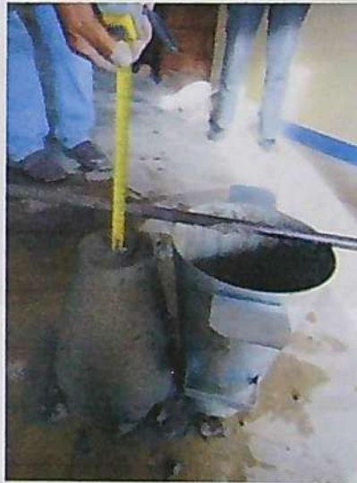
FOTOGRAFÍA N° 14: Medición del revenimiento o slump de la mezcla haciendo uso del método del cono de Abrahams. Para el presente trabajo de investigación el slump de diseño fue establecido en 2 a 3 pulgadas, lo cual se cumplió tal como se muestra en la fotografía.
