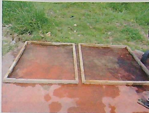
FOTOGRAFÍA N° 49: Preparación de los moldes de madera de 1.00x1.00x0.05 metros para efectuar el ensayo de fisuración al aire libre.
