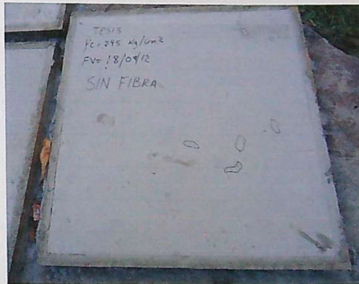
FOTOGRAFÍA N° 56: En esta foto se pueden apreciar las fisuras que aparecieron en la losa con concreto cemento – arena sin refuerzo de fibras f'c=245 Kg/cm 2 . Las fisuras aparecieron 1h 30m luego del llenado de la losa.
