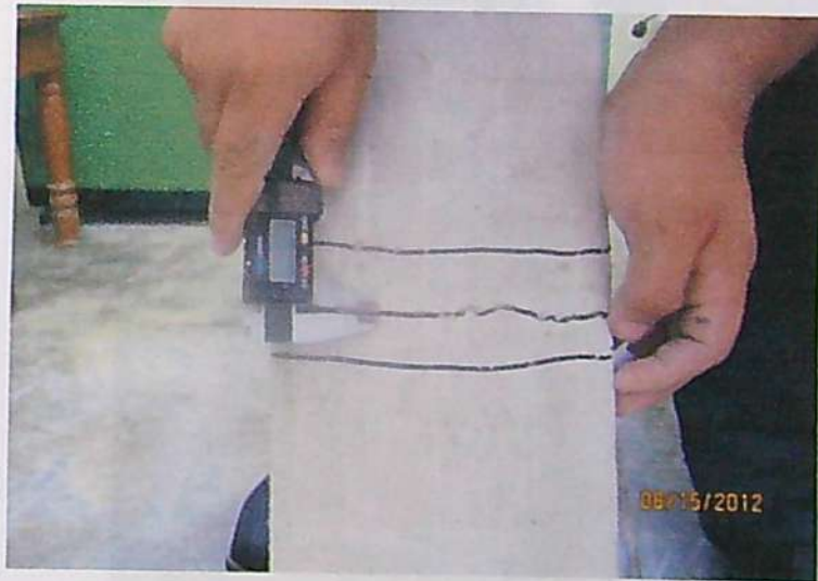
FOTOGRAFÍA N° 45: Fisura de 2.5 milímetros de ancho formada en una viga reforzada con fibras. Se trata de la fisura más ancha observada en los ensayos.
