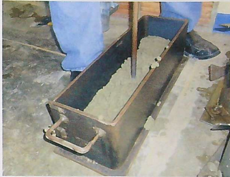
FOTOGRAFÍA N° 27: Preparación de la viga a ensayar a flexión en molde normativo.
