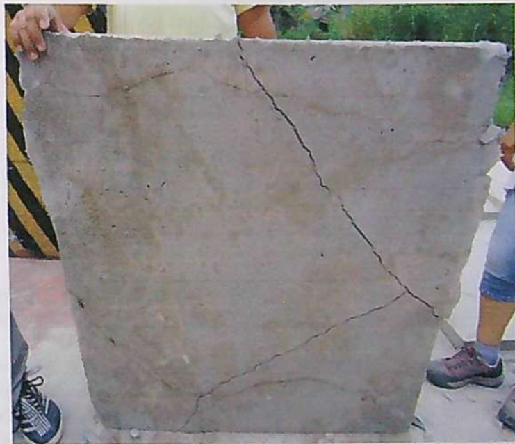
FOTOGRAFÍA N° 58: Fisuración en la parte inferior de una de las losas sin fibras.
