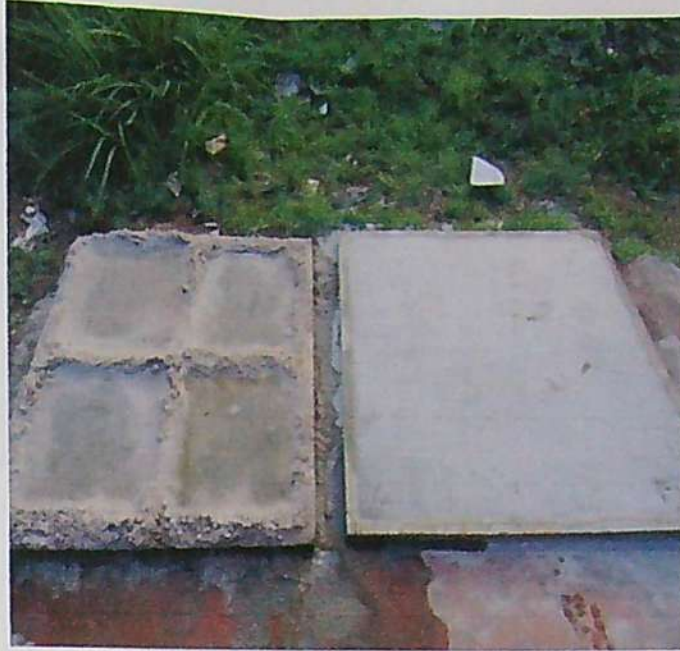
FOTOGRAFÍA N° 53: En la vista se aprecian dos losas reforzadas con fibras. La del lado izquierdo está siendo curada y la del lado derecho no recibió curado alguno. Ninguna de las dos presentó fisuras.
