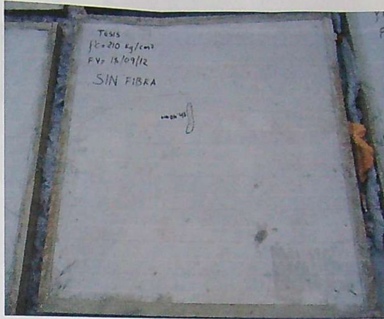
FOTOGRAFÍA N° 55: En esta foto se puede apreciar la fisura que apareció en la losa con concreto cemento – arena sin refuerzo de fibras f'c=210 Kg/cm 2 . La fisura apareció 1h 40m luego del llenado de la losa.
