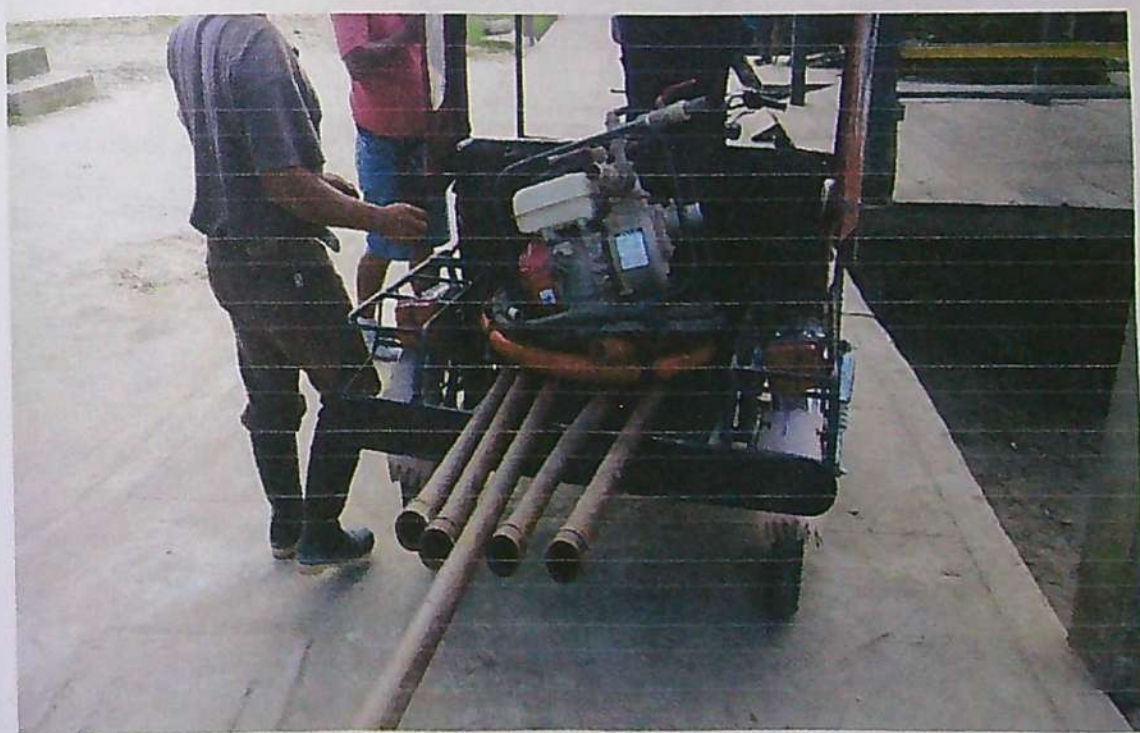
Foto 26: Herramientas y equipos para la ejecución de las perforaciones.
