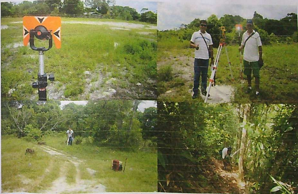
Foto 16- Los equipos topográficos, estación total y GPS, levantamiento topográfico del área de la Tesis.
