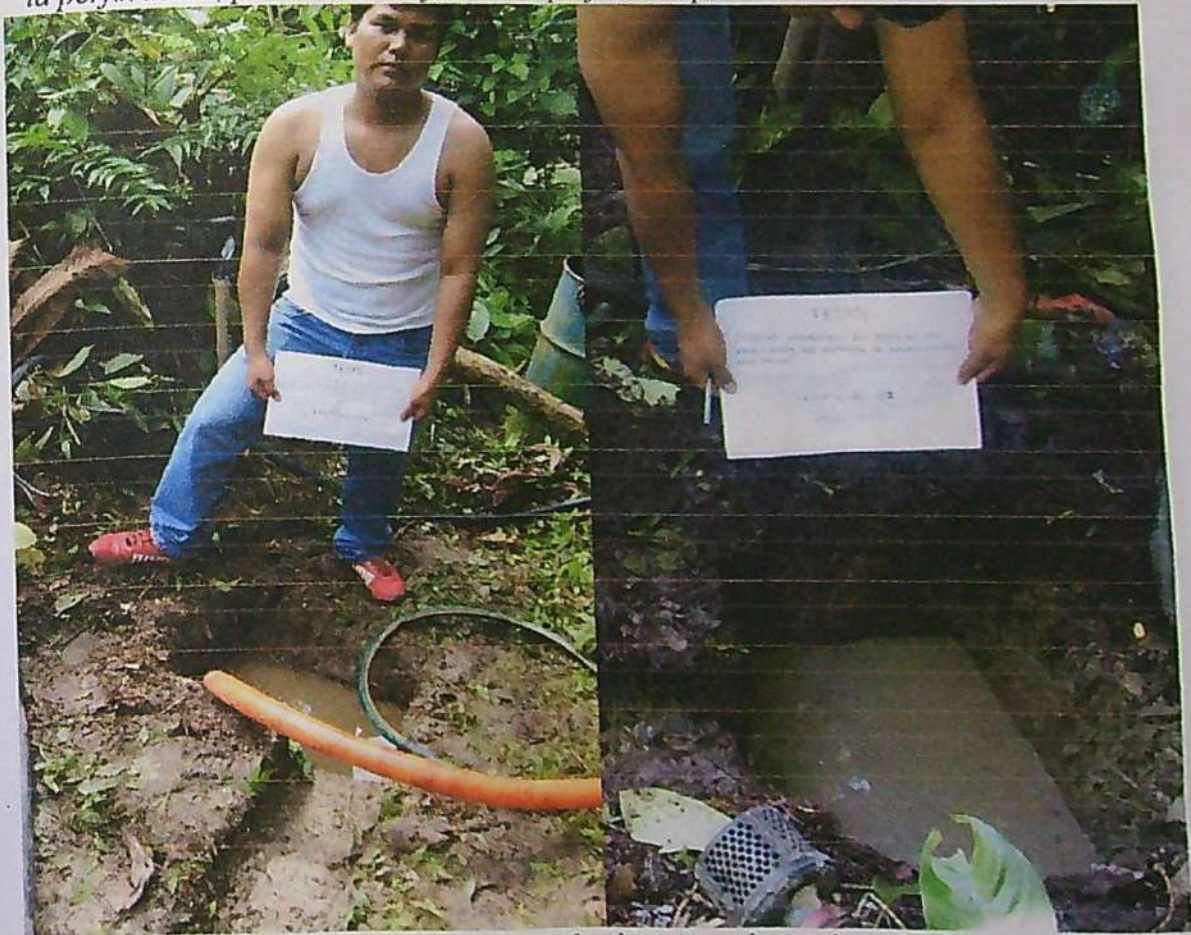
Foto 34: Perforaciones 02 y 03, se verifica las zanjas de recolección de estratos de suelos.
