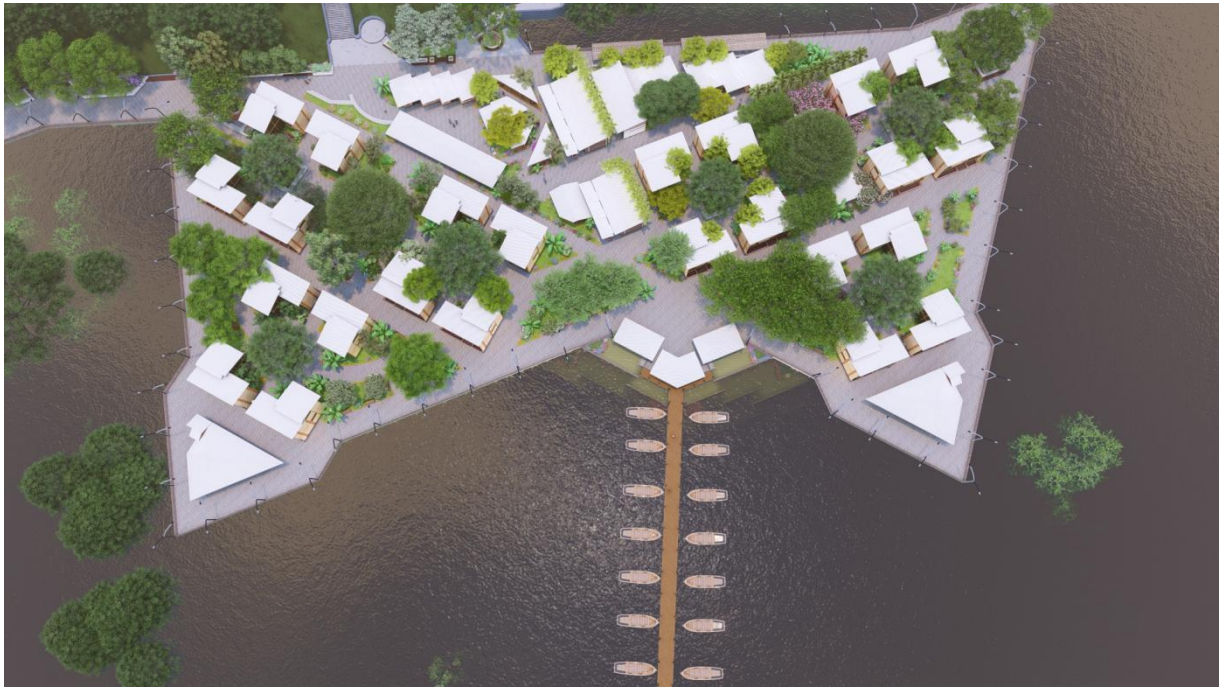
Imagen N° 50: Vista general del conjunto,
