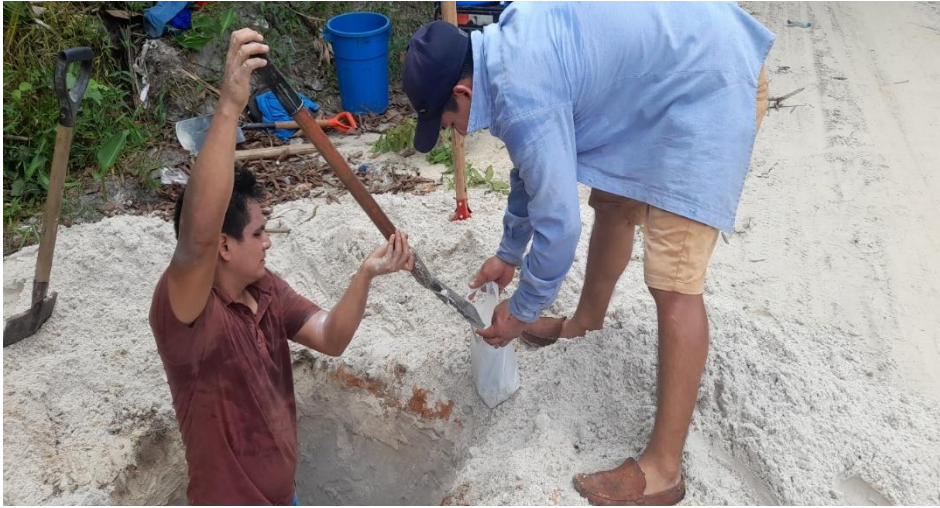
FOTO N°13: TOMA DE MUESTRAS 01 EN CALICATA 03
