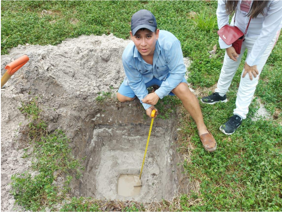
FOTO N°40: C-2 TEST DE PERCOLACIÓN
