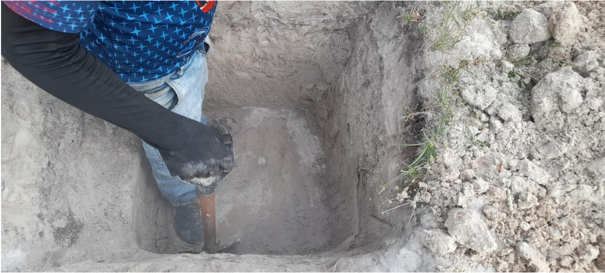
FOTO N°28: EXCAVACIÓN CALICATA 07
