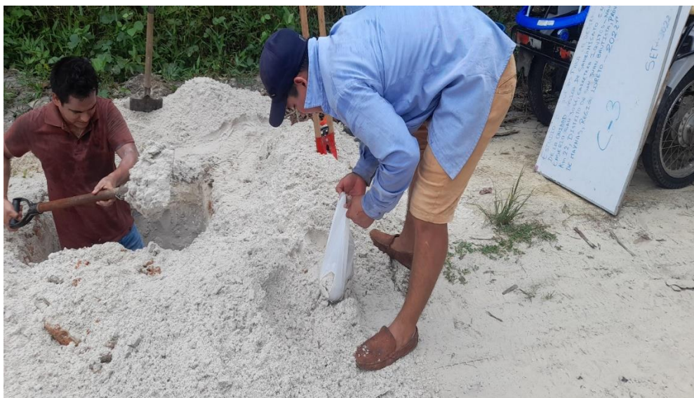
FOTO N°12: TOMA DE MUESTRAS 01 EN CALICATA 03
