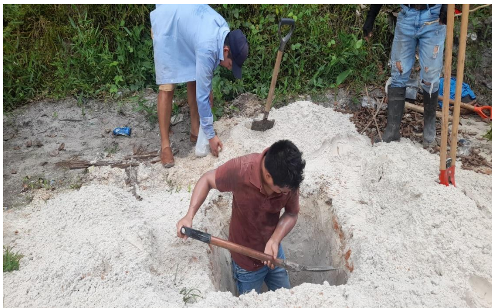
FOTO N°11: EXCAVACIÓN DE LA CALICATA 02
