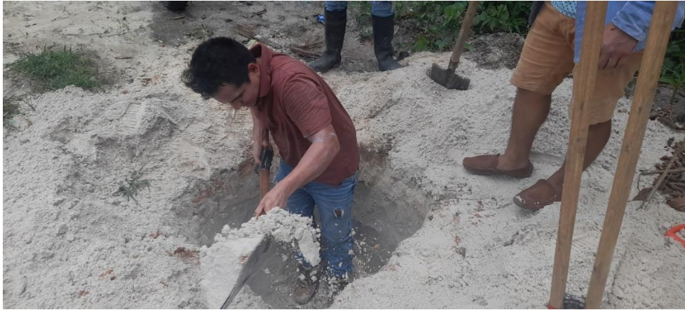
FOTO N°10: EXCAVACIÓN DE LA CALICATA 02
