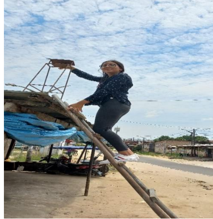
Figura 26. Colocación de placas de captación de PAS en la Av. Participación (AV 2-3).
