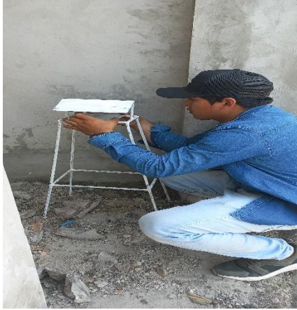
Figura 25. Instalación de plataforma de placa en la Av. Quiñones (AV 1-2).
