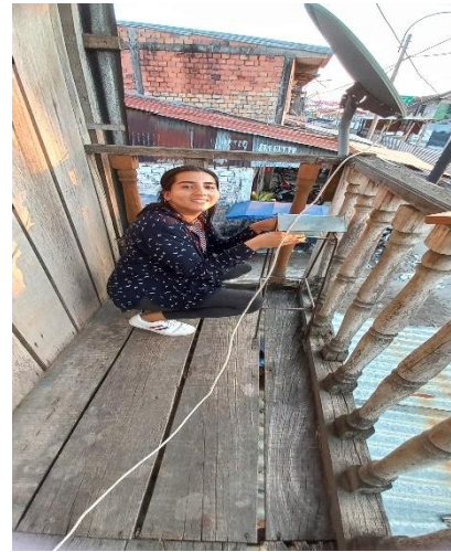
Figura 30. Instalación de plataforma de placa en la Av. Marina (AV 3-4).
