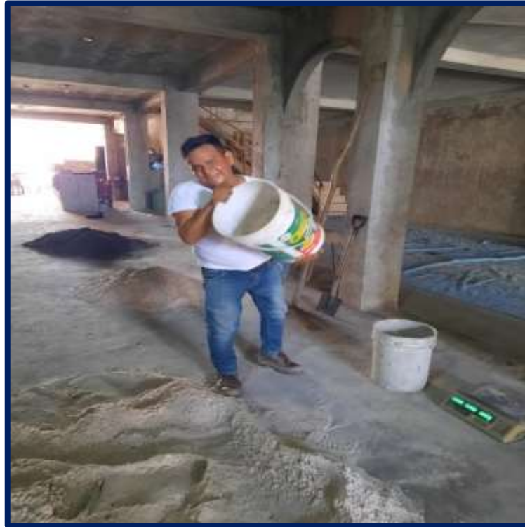
Foto 9: INICIO DEL MESCLADO DE LOS MATERIALES: CEMENTO, ARENA, AGUA Y PET DE FORMA MANUAL.
