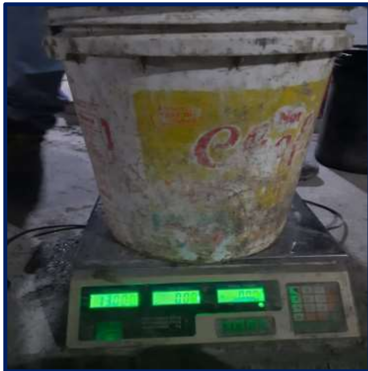
Foto 8: PESADO DE LOS MATERIALES: CEMENTO, ARENA, AGUA Y PET.
