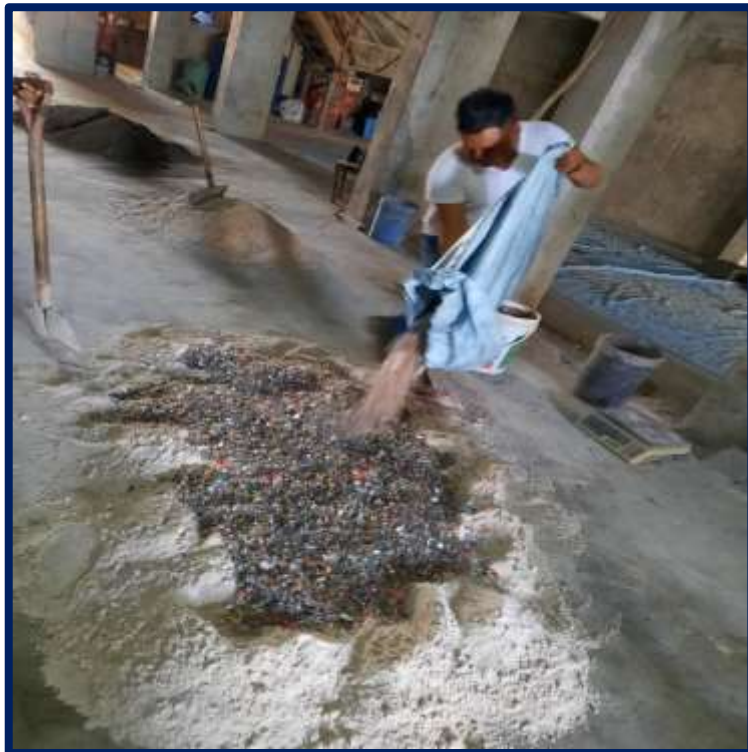
Foto 10: INICIO DEL MESCLADO DE LOS MATERIALES: CEMENTO, ARENA, AGUA Y PET DE FORMA MANUAL.
