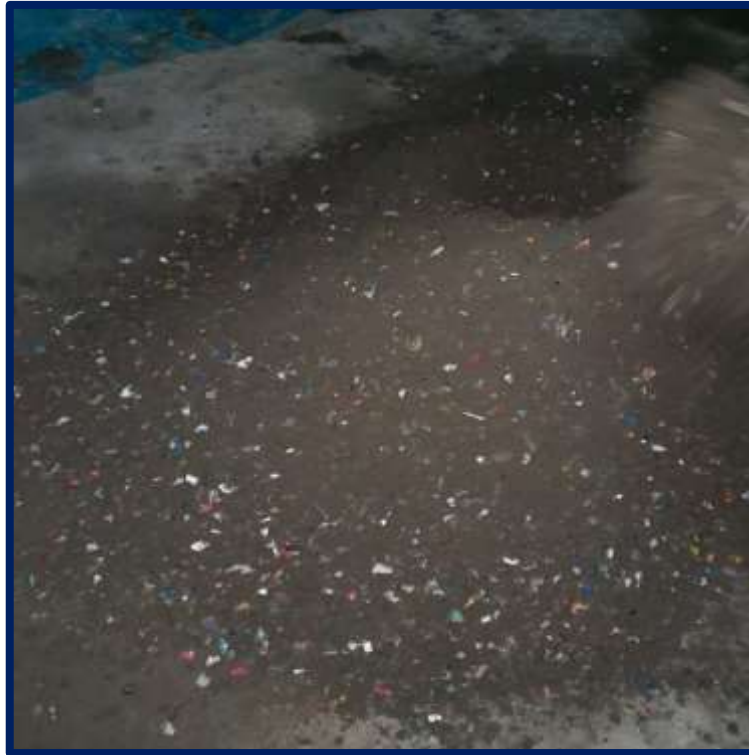
Foto 11: INICIO DEL MESCLADO DE LOS MATERIALES: CEMENTO, ARENA, AGUA Y PET DE FORMA MANUAL.
