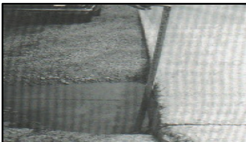
Figura 23. Desnivel carril – berma de severidad media. Fuente: Pavement Condition Index (PCI).
