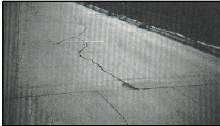
Figura 10. Losa Dividida de baja severidad. Fuente: Pavement Condition Index (PCI).
