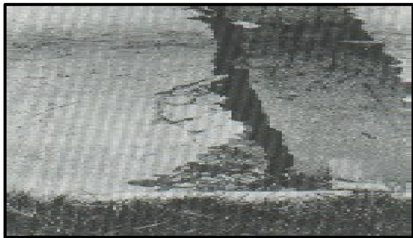
Figura 4. Blowup - Buckling (Rotura por Pandeo) de baja severidad-Fuente: Pavement Condition Index (PCI).
