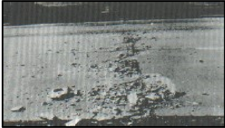
Figura 4. Blowup - Buckling (Rotura por Pandeo) de baja severidad-Fuente: Pavement Condition Index (PCI).
