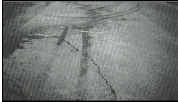
Figura 10. Losa Dividida de baja severidad. Fuente: Pavement Condition Index (PCI).
