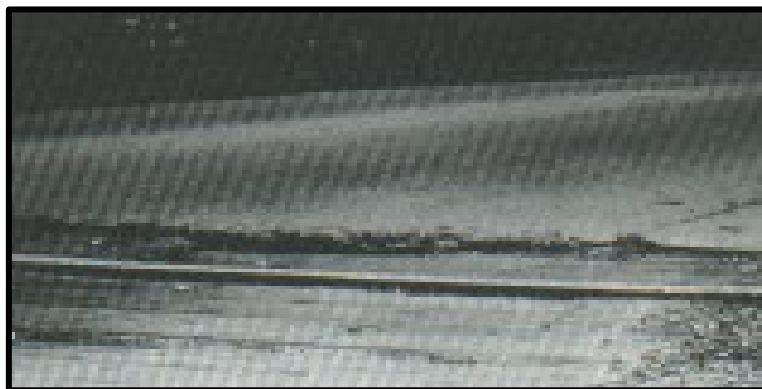
Figura 42. Cruces de vía férrea de severidad media. Fuente: Pavement Condition Index (PCI).
