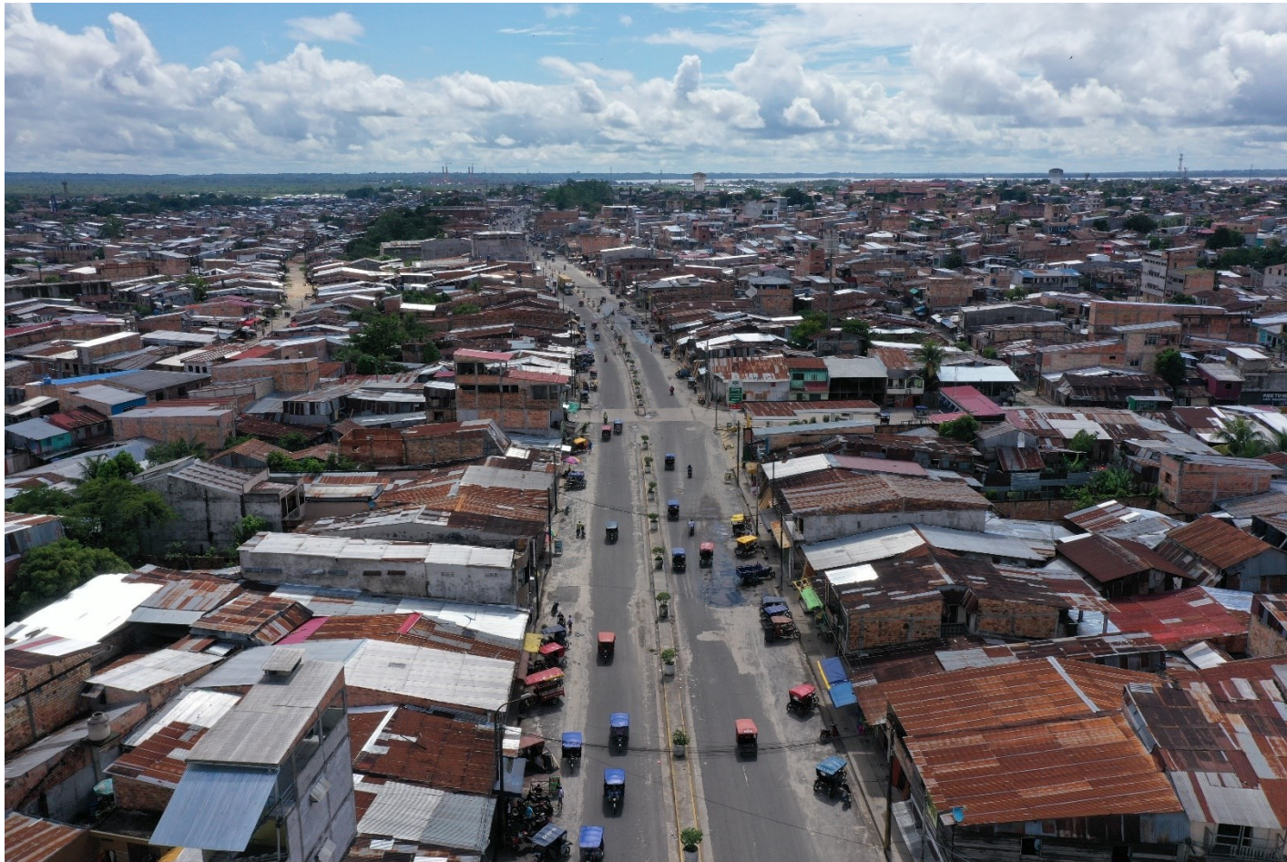
IMAGEN CON DRON DE AV. NAVARRO CAUPER
