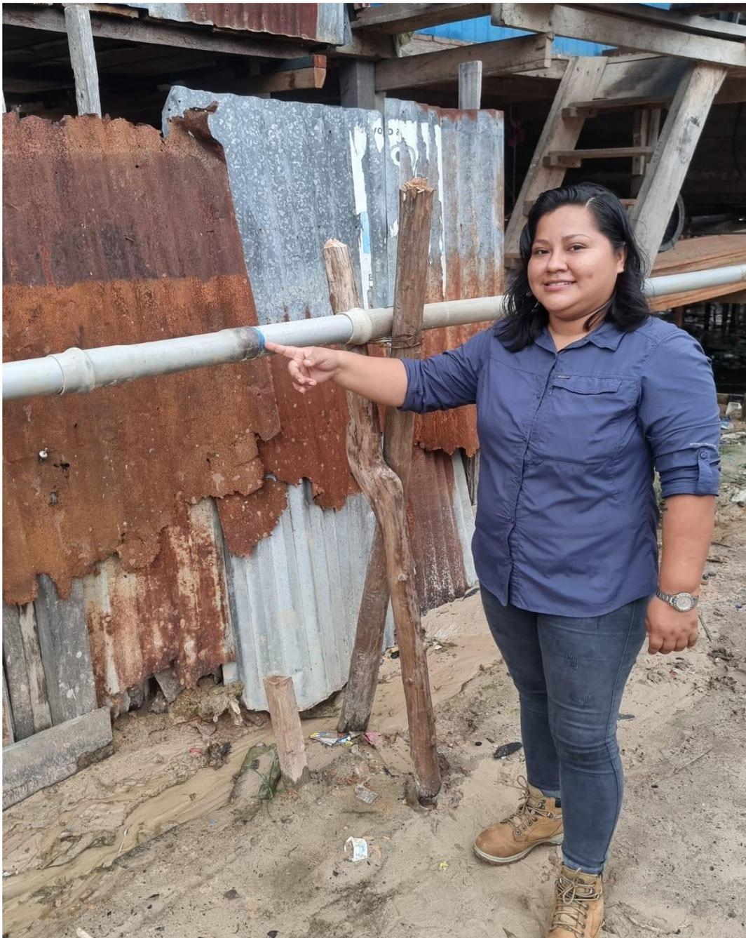
FOTO: Tuberías de distribución expuestas.
