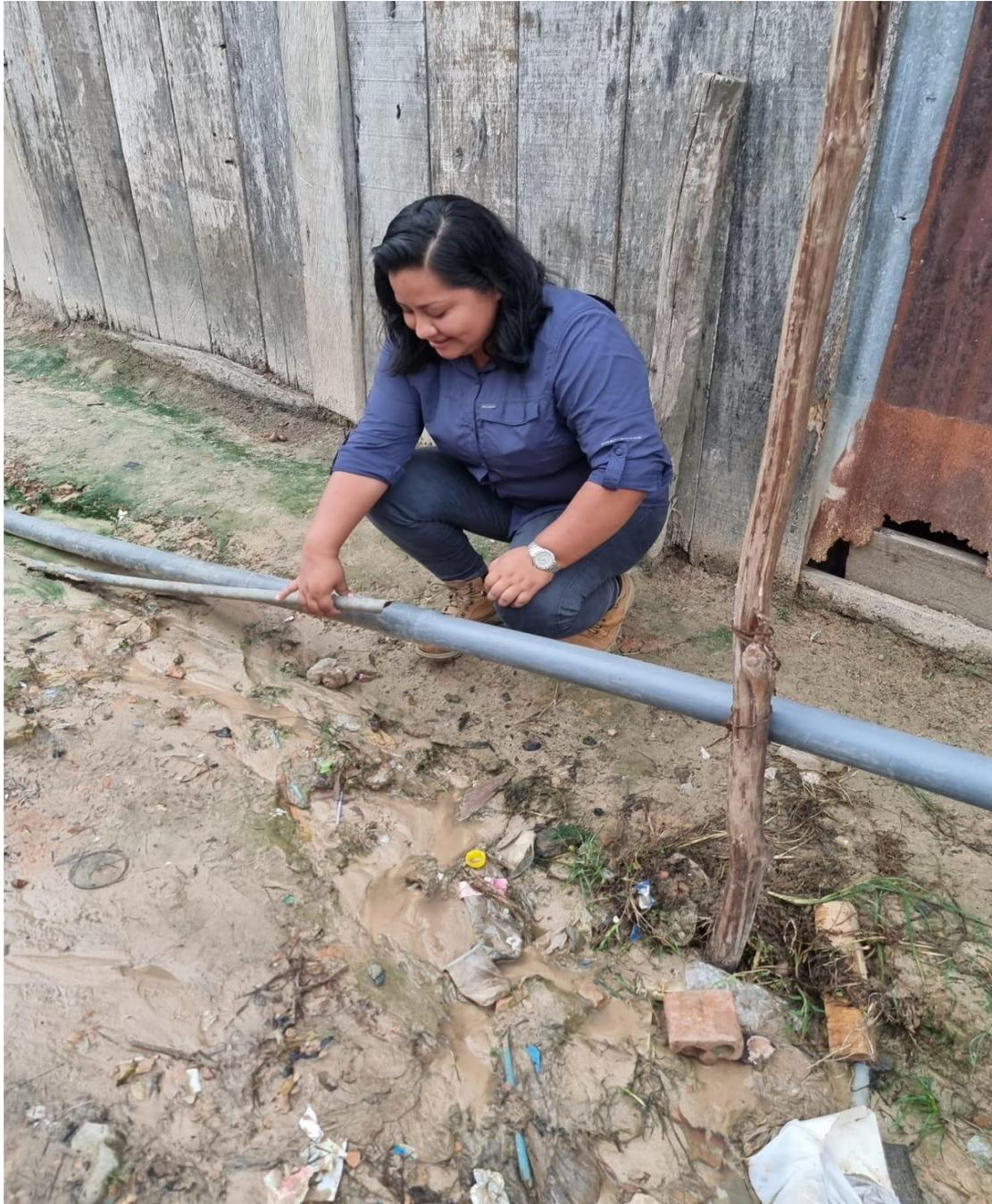
FOTO: Tuberías de conexión domiciliaria colmatadas.
