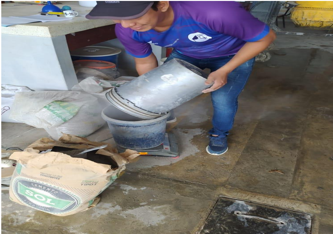
FOTO N° 24: Materiales listos para su posterior vaciado en la mezcladora (Trompo de 9 pies).
