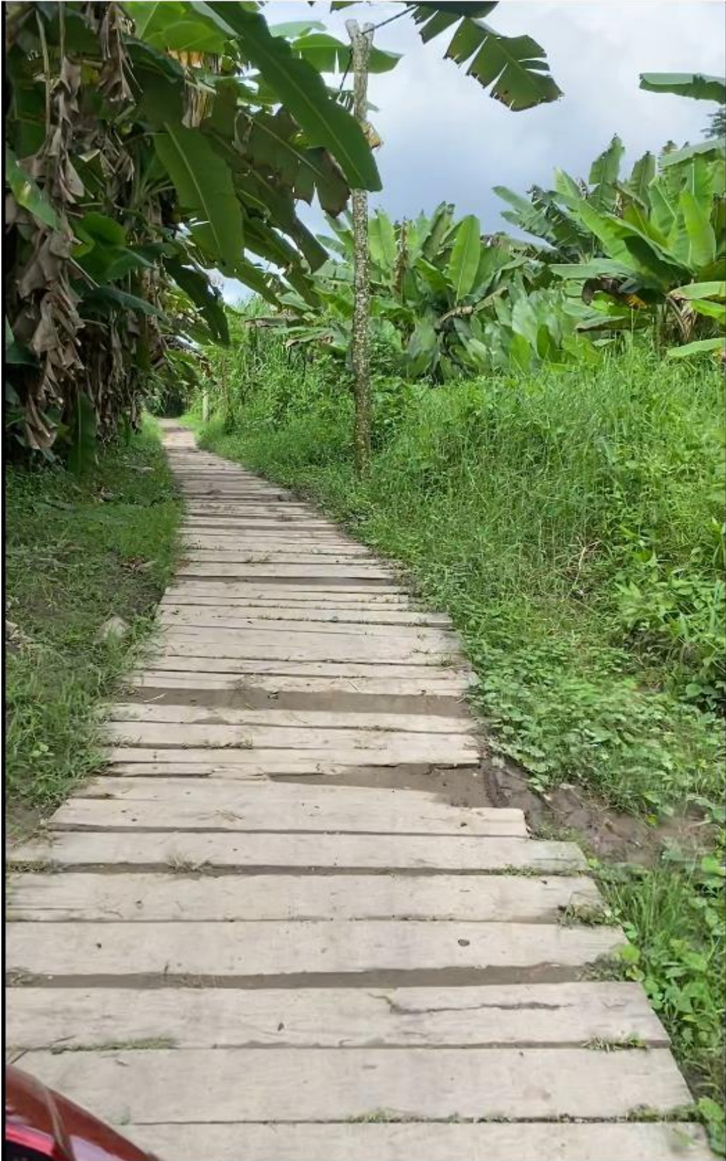
FOTO 05: ENTRADA A LA COMUNIDAD DE CANTA GALLO CUBIERTA CON TABLAS PARA FACILITAR EL ACCESO
