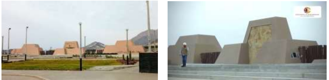
Figura 50 Avance de construcción del CEN
