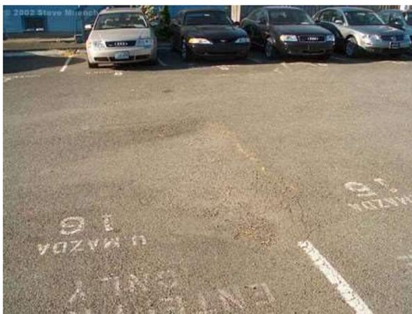
“Las distorsiones y desplazamientos que ocurren sobre grandes áreas del pavimento causando extensas o largas depresiones en el mismo, se llaman “ondulaciones” (hinchamiento: swelling). Si aparecen en un patrón perpendicular al flujo del tránsito y están espaciadas a menos de 3.0 m, el daño se llama corrugación (Falla 5).” (Corros B., Ernesto, & Gustavo, 2009)
