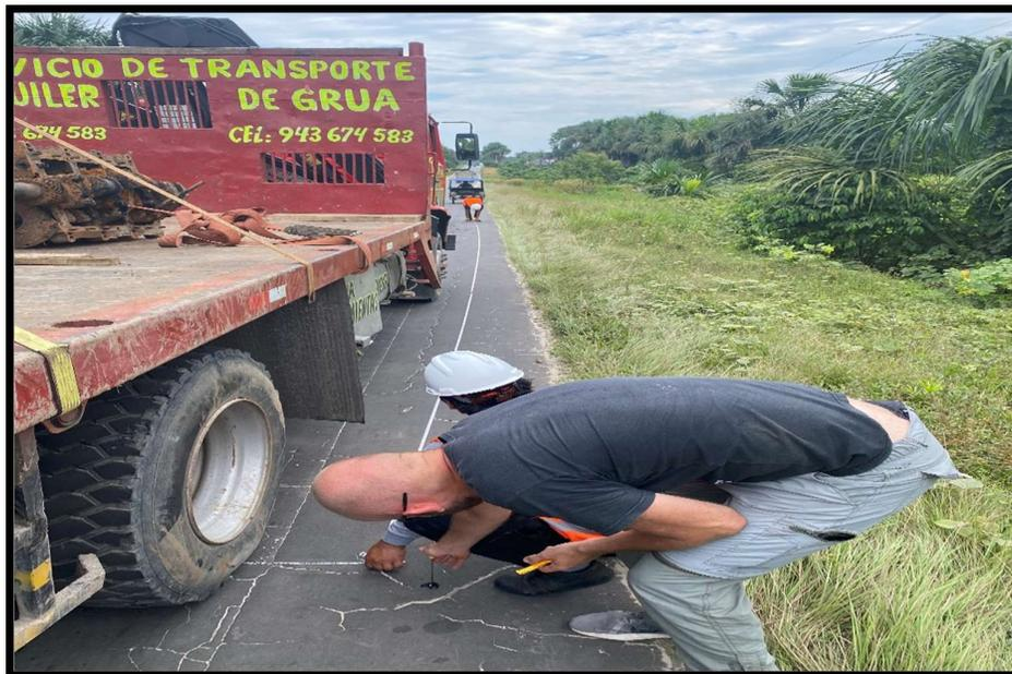
*Fotografía 8 Medición de la distancia entre un punto a otro utilizando un flexómetro*
