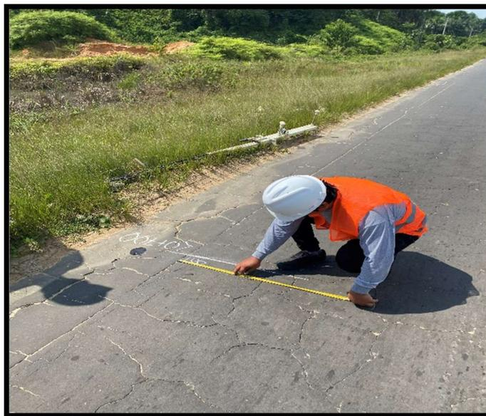
*Fotografía 2 Medición y Trazado de Línea Transversal para cada Punto de Ensayo*
