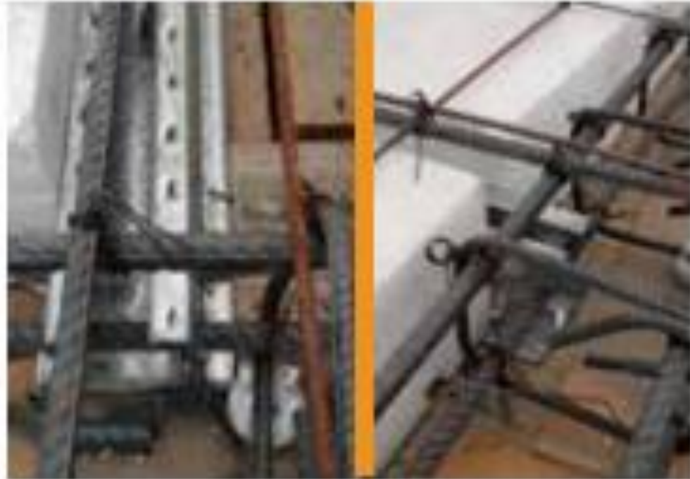
FIGURA N° 7 ESTRIBOS PARA VIGAS CHATAS
