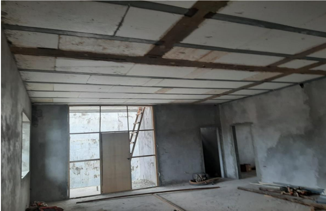
INTERIORES DEL SEGUNDO PISO
