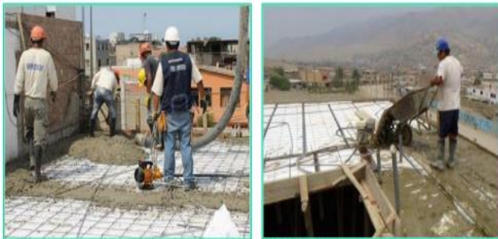
FIGURA N° 21 VACIADO DEL CONCRETO EN EL ENTREPISO
