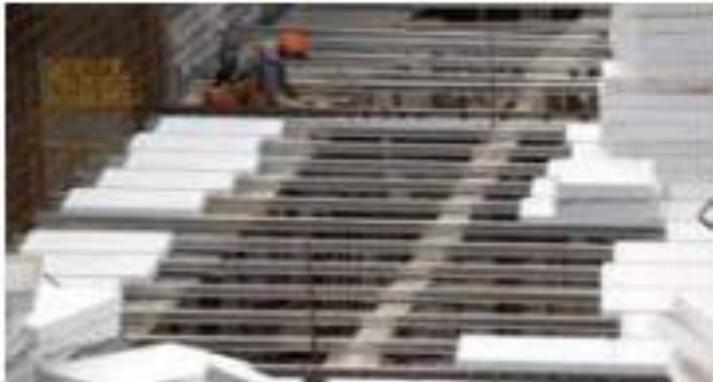
FIGURA N° 8 INSTALACIÓN DE LOS CASETONES
