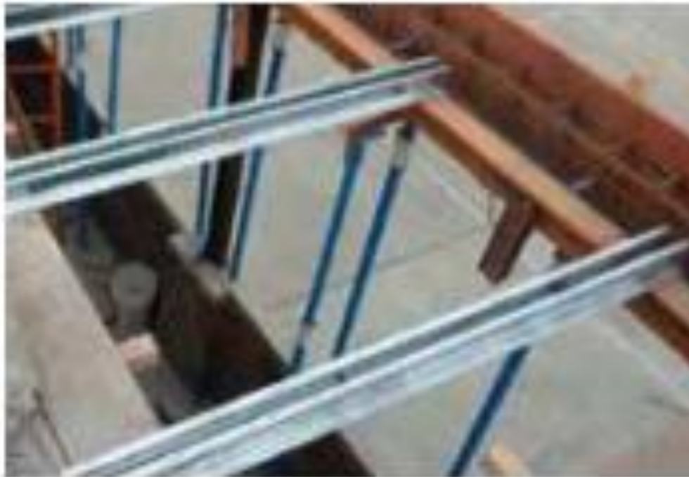
FIGURA N° 6 COLOCACIÓN DE LAS VIGETAS DE ACERO CORRUGADO
