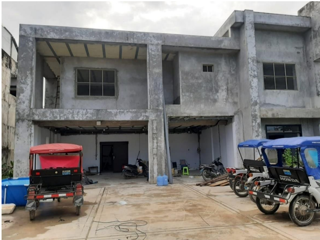
VISTA DE INGRESO DE LA COCHERA
