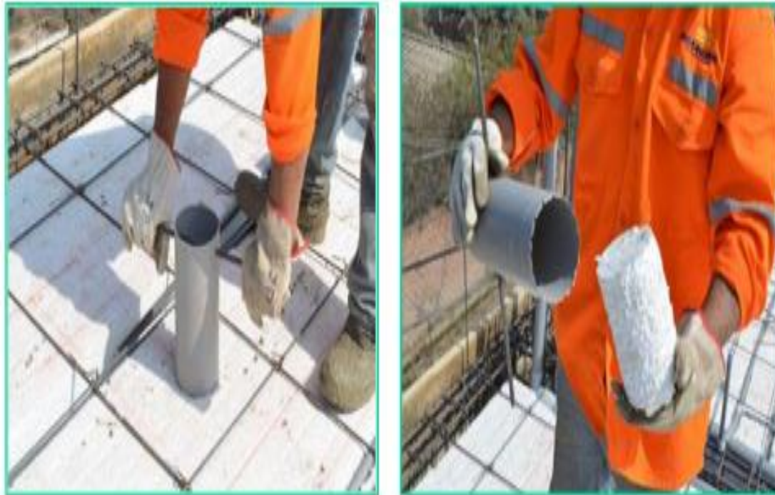
FIGURA N° 9 PROCESO DE LAS INSTALACIONES ELÉCTRICAS
