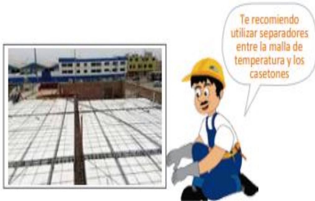
FIGURA N° 19 COLOCACIÓN DE MALLAS ELECTROSOLDADAS
