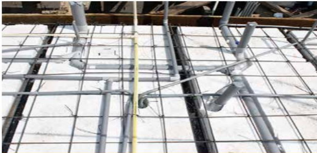
FIGURA N° 14 LIMPIEZA Y PRUEBA DE LAS INSTALACIONES SANITARIAS
