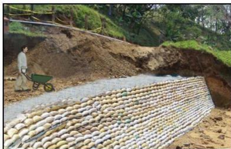
Ilustración 20: DETALLE CONSTRUCTIVO CON GAVIONES TIPO SACO
